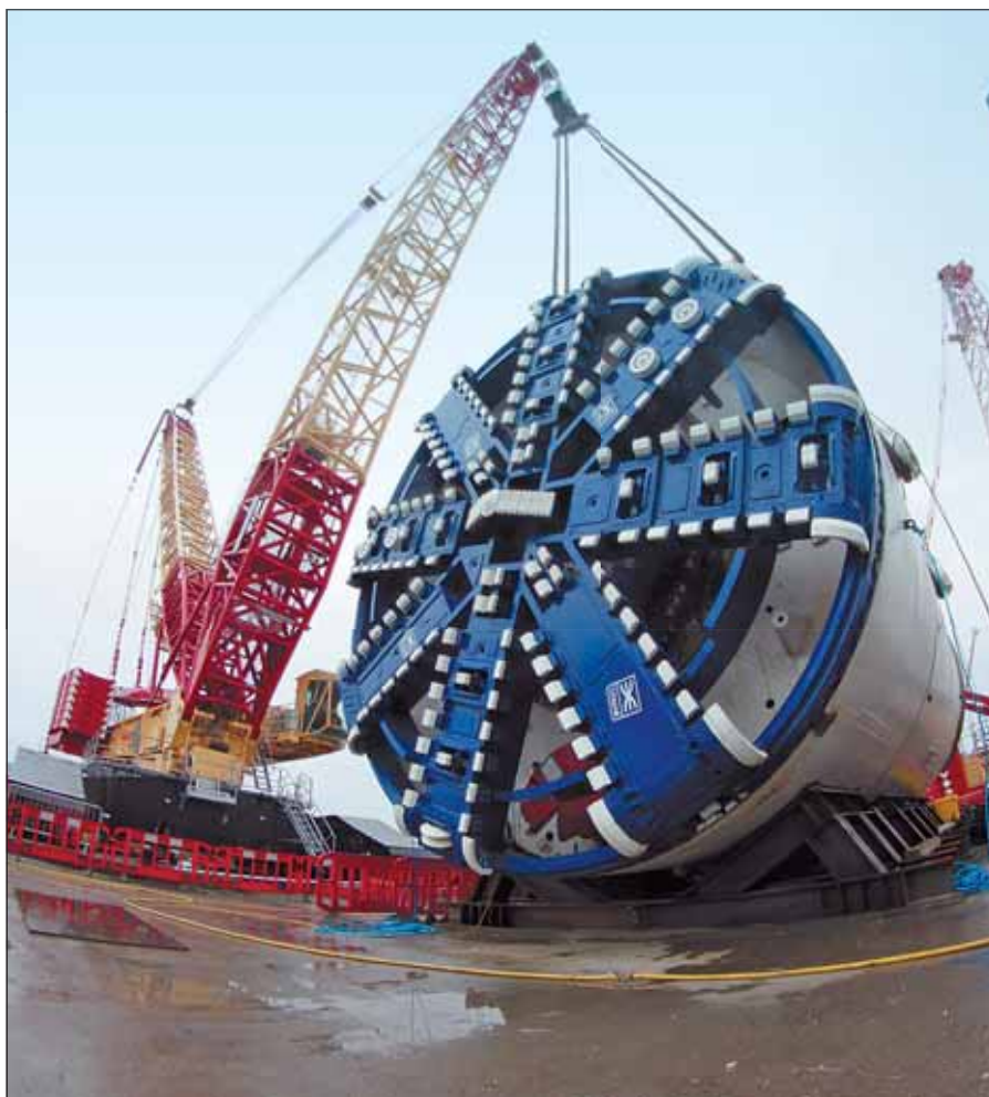
Budowa Crossrail – linii metra łączącej wschodnią i zachodnią część Londynu: opuszczanie do głównego szybu „Elizabeth” – maszyny drążącej tunel (zdjęcie z października 2012)
