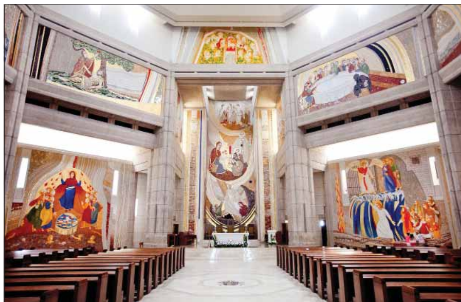
Ośmioboczne monumentalne wnętrze głównej nawy kościoła górnego. Filary naw bocznych i wiele innych elementów konstrukcyjnych wykonano z betonu architektonicznego rzeźbionego w masie. Nawę główną zamknięto pozornym sklepieniem odciętym od ścian bocznych w formie parasola. Wnętrza kościoła górnego zdobią mozaiki autorstwa o. Marko Rupnika, słoweńskiego jezuitę.
