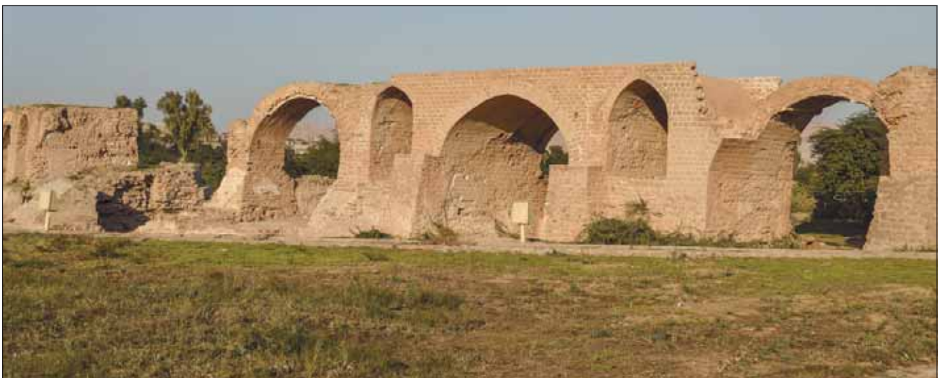
Most-zapora Cezara na rzece Korun w Shushtar (fot. K. Ryż)
