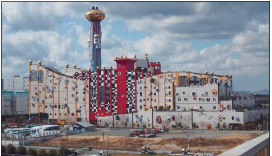
Spalarnia odpadów Maishima Incineration Plant w Osace (Japonia). Autorem projektu architektonicznego był u schyłku życia F. Hundertwasser. Pracę tę wykonał na zlecenie burmistrza Osaki, który specjalnie obejrzał wiedeńską spalarnię, zauroczył się nią i postanowił podobnie ukształtować budowaną wówczas (w połowie 90.) spalarnię w Osace.
