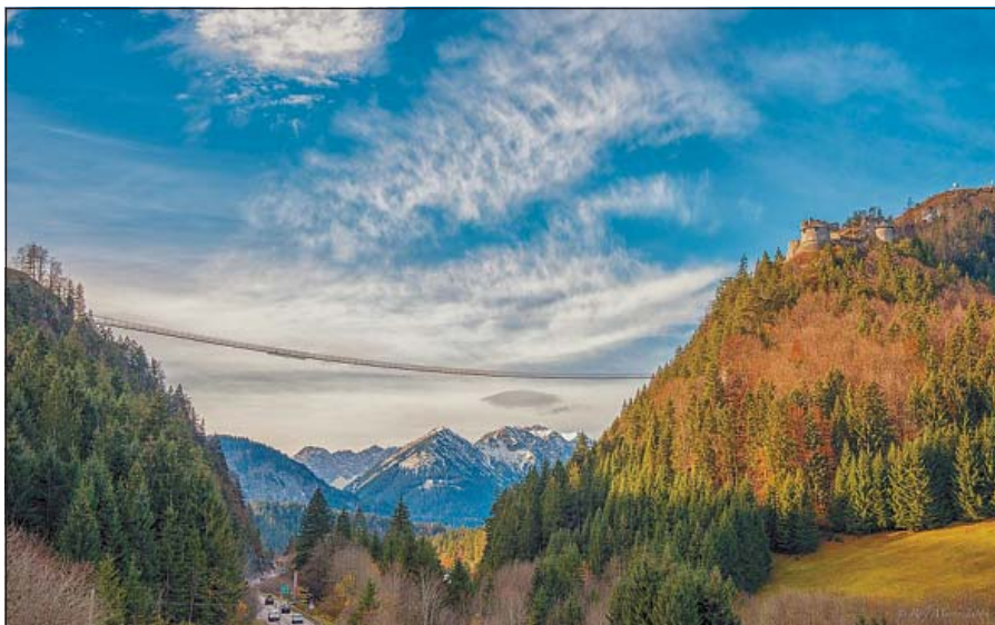
Widok kładki Highline 179 z poziomu drogi 179.
