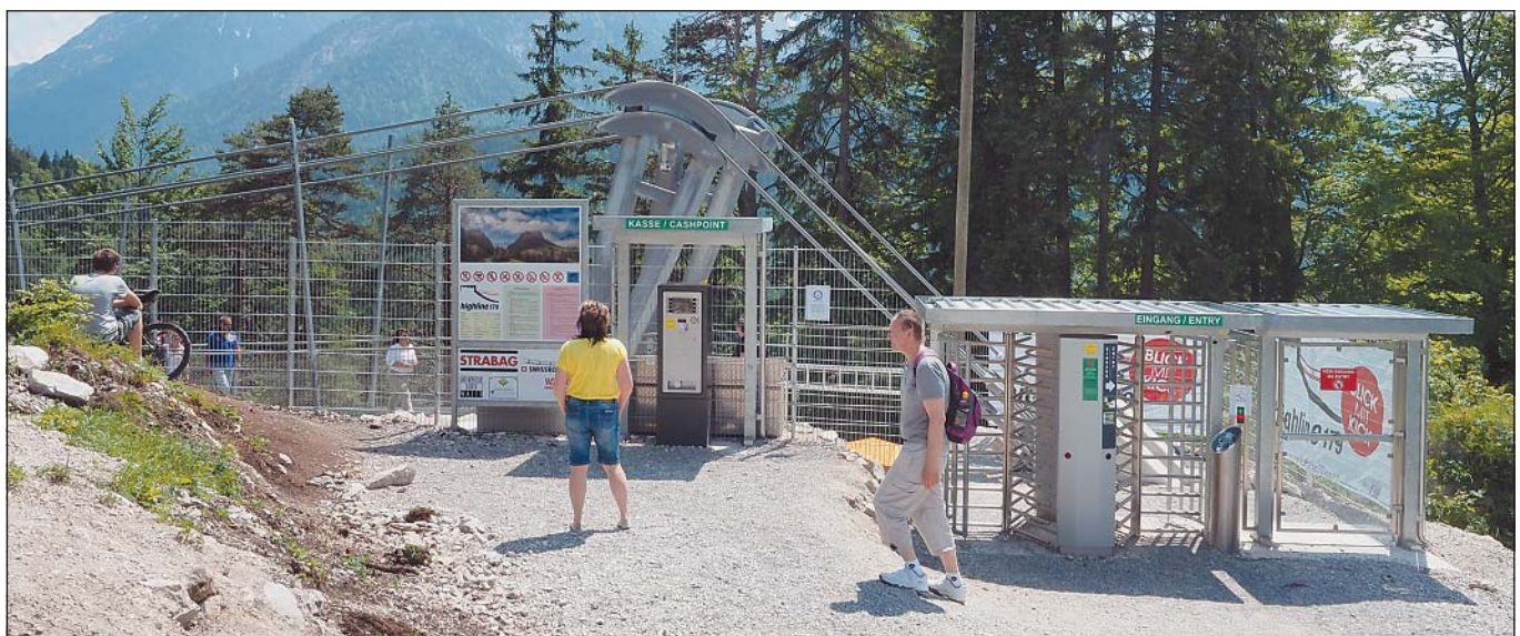
Strefa wejściowa na kładkę po stronie zamku Ehrenberg.
