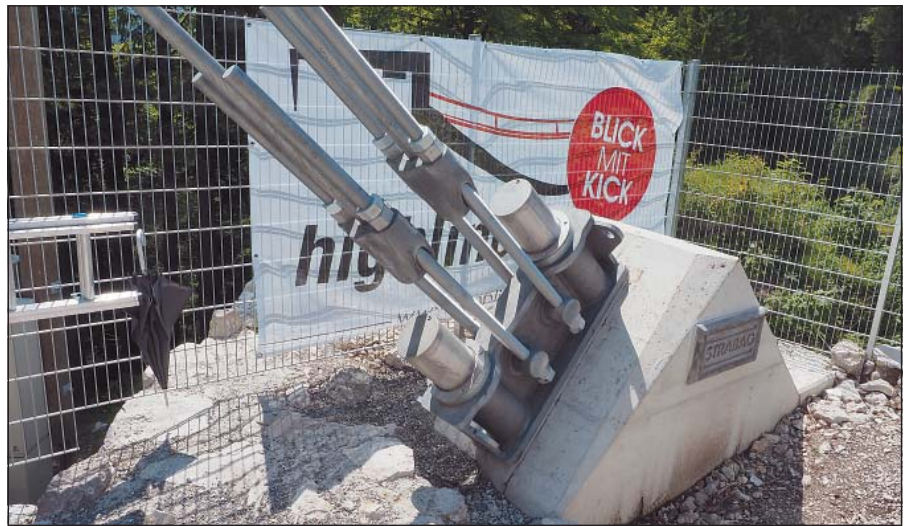
Typowe zakotwienie lin głównych z elementami rektyfikacyjnymi.
