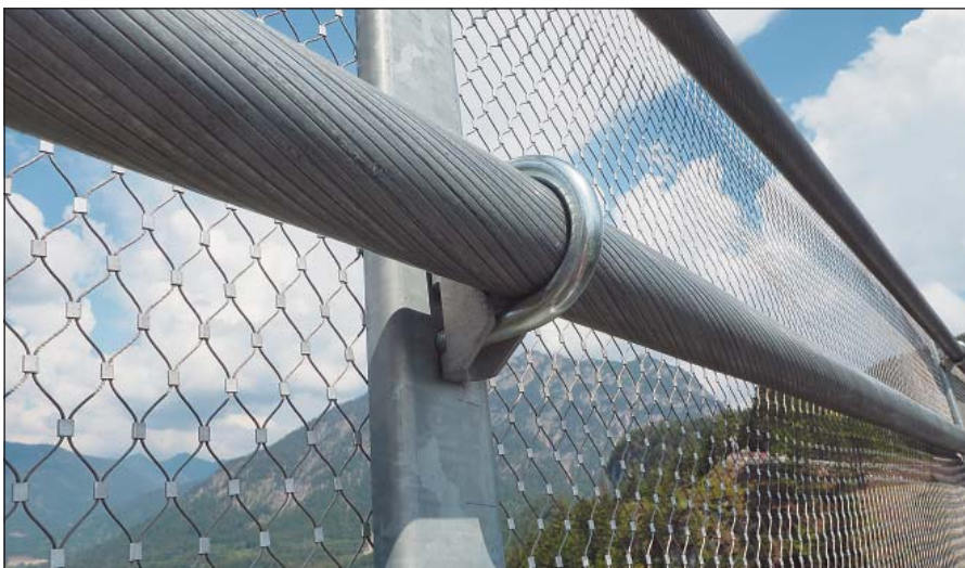
Zamknięta lina główna wraz z zaciskiem kabłąkowym.
