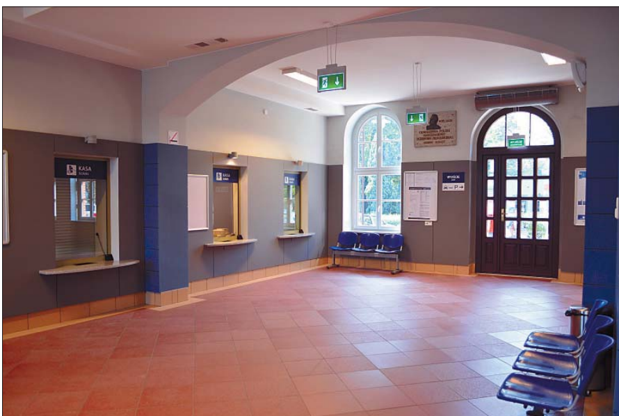
Dworzec Pszczyna po modernizacji - hol
