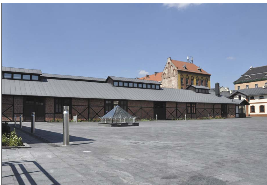
Dziedziniec muzeum po zakończeniu prac rewaloryzacyjnych w ramach projektu „Kwartal św. Wawrzyńca – budowa centrum kulturowego na krakowskim Kazimierzu”. Ze zbiorów Muzeum Inżynierii Miejskiej.
