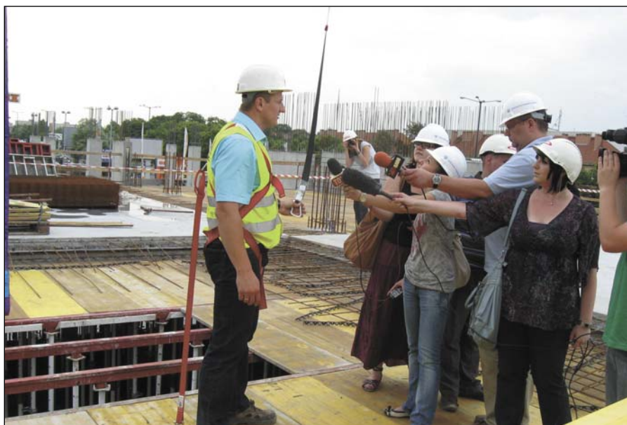
Konferencja prasowa na budowie – prezentacja systemu Alsina.
