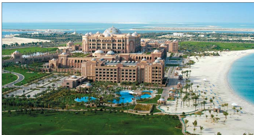
Widok ogólny zespołu hotelowego Emirates Palace (źródło internetowe)
