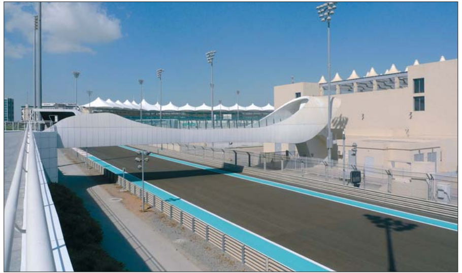
Kładka pieszo-jezdna nad fragmentem toru
