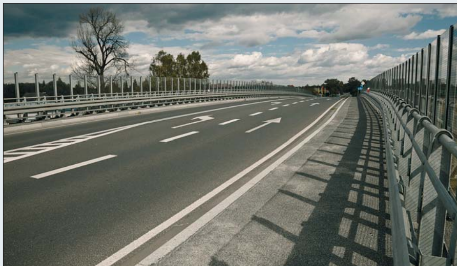
Modernizacja drogi woj. nr 933 wraz z budową wiaduktu w m. Kroczymiech
