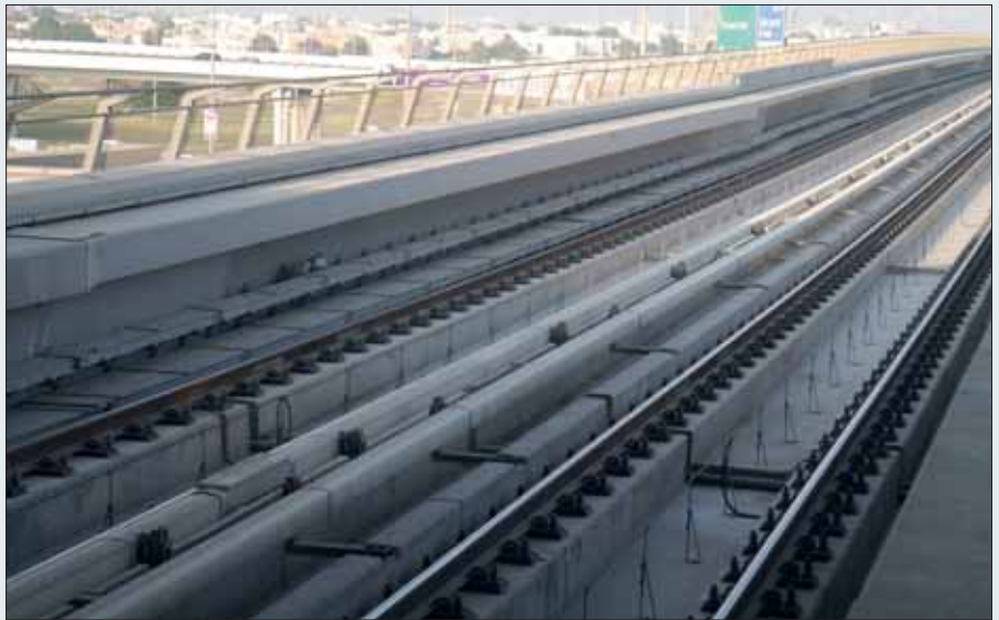
Konstrukcja torów metra na estakadzie
