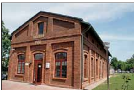
Budynek byłej fabryki amoniaku
