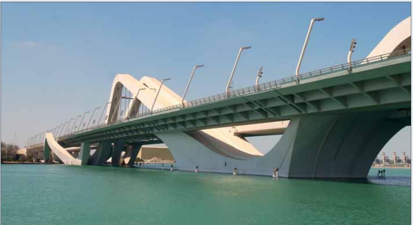
Most Zayed w Abu Dhabi – widok na główne przęsło łukowe wraz z dźwigarem skrzyniowym
