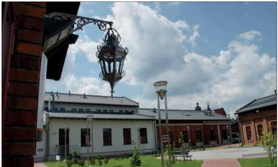
Budynek byłej aparatuwni i kotłowni
