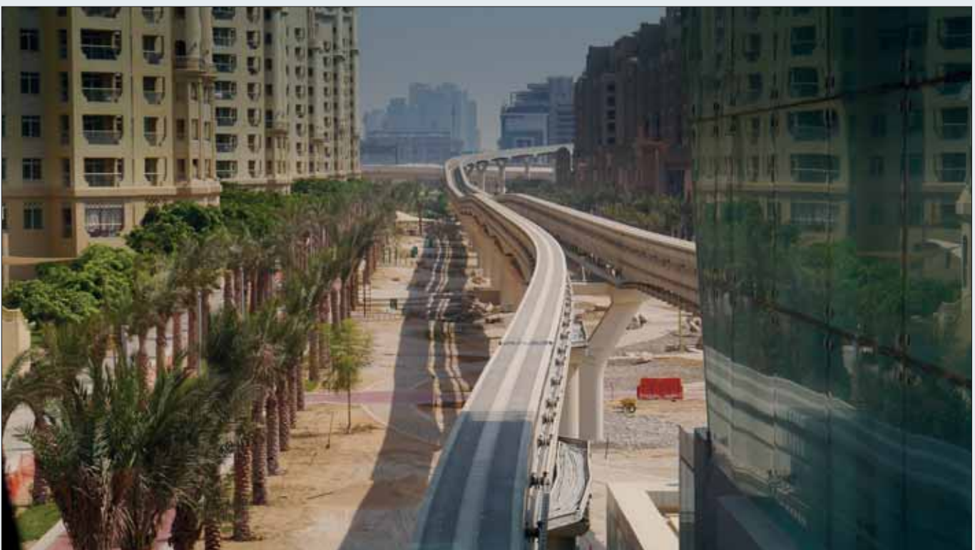
Dźwigary betonowe (szyny) kolei w obrębie zabudowanego pnia wyspy
