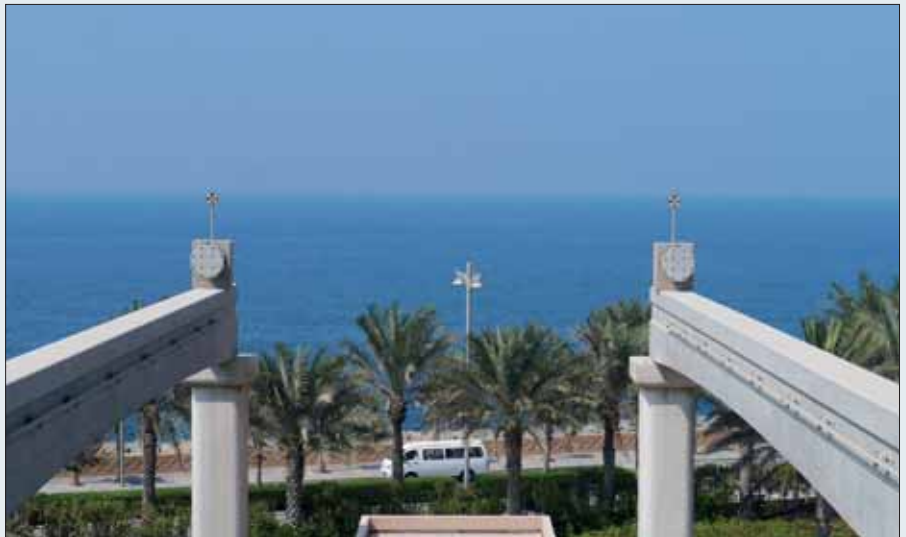
Terminal kolei jednoszynowej na szczycie palmy obok hotelu Atlantis
