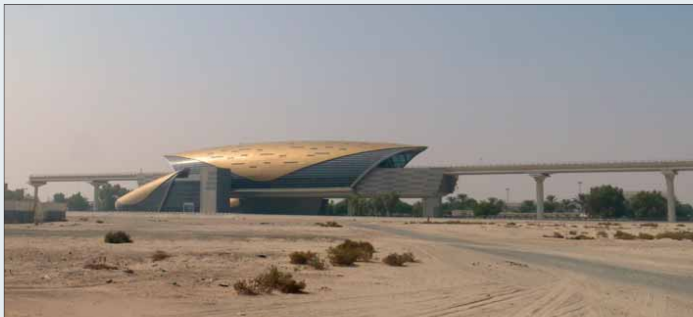
Końcowa stacja zielonej linii metra
