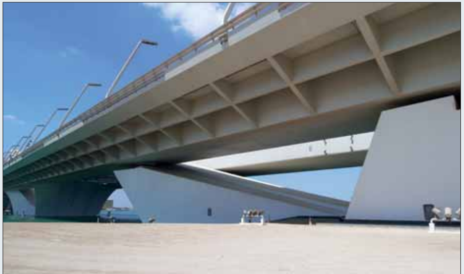
Dźwigar skrzyniowy mostu Zayed
