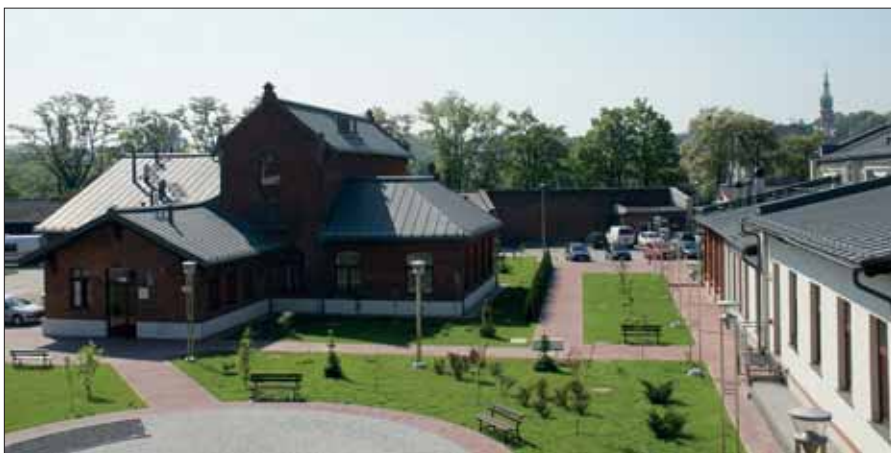
Budynek byłej fabryki gazu wodnego
