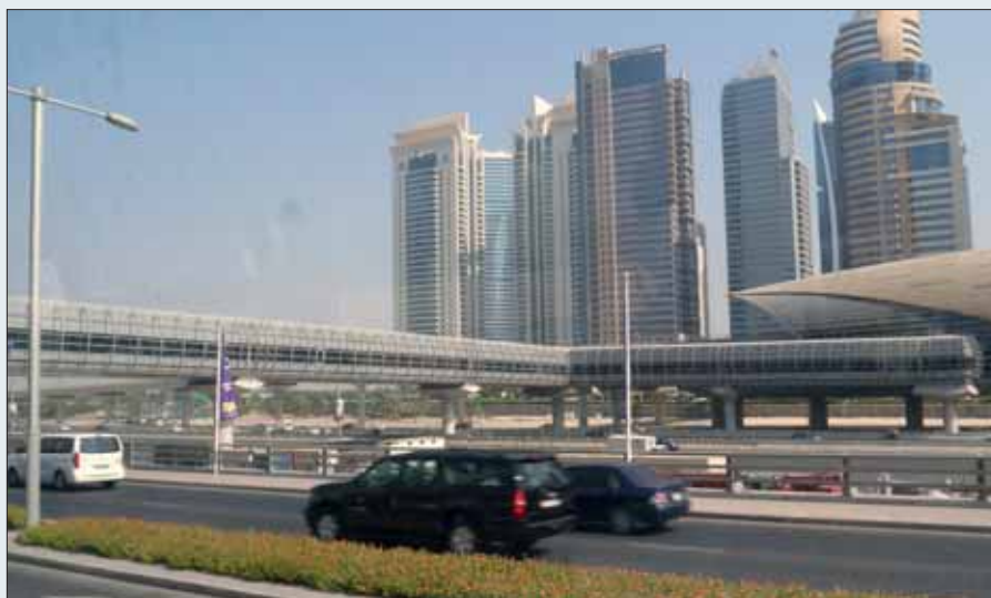
Obudowana kładka dla pieszych – dojście do stacji metra nad dwujezdniową arterią komunikacyjną
