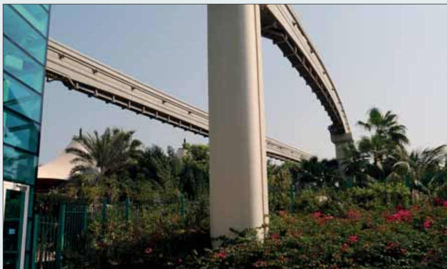
Dźwigiary betonowe (szyny) kolei w obrębie falochronu wyspy
