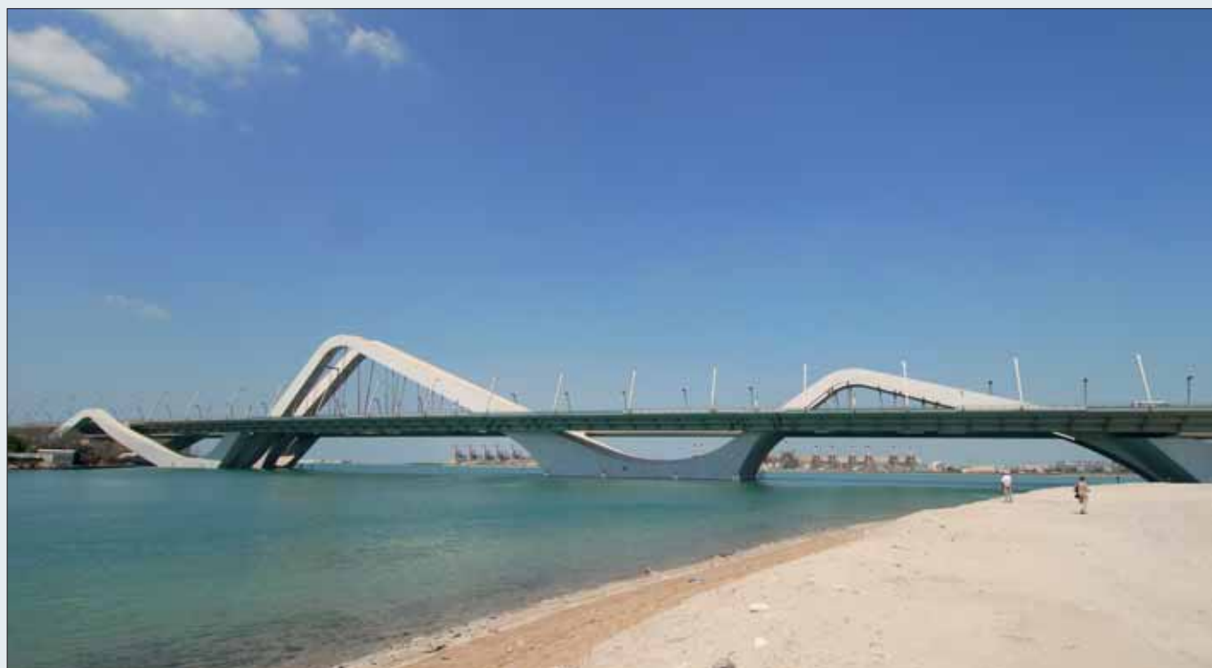
Most Zayed w Abu Dhabi – widok ogólny
