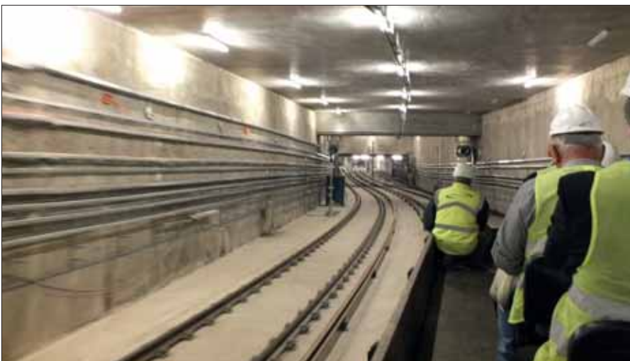
Zwiedzanie budowy 4 linii metra
