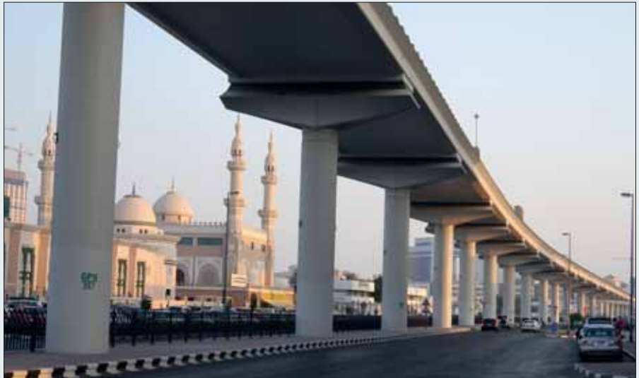
Estakada zielonej linii metra w Dubaju
