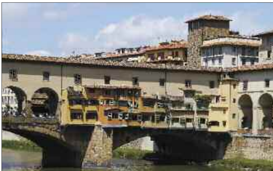
(Fot. 6) Most Vecchio. Prześło skrajne z Korytarzem Vasarięgo i nadwieszoną, podpartą kroksztykami zabudową sklepów złotników. (fot. K. Ryż).
