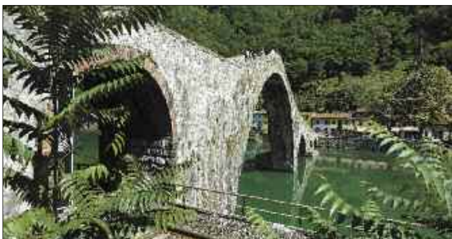
(Fot. 3) Dobudowane na początku XX wieku przeszło sklepione nad linią kolejową Aulla-Lucca. (fot. K. Ryz).
