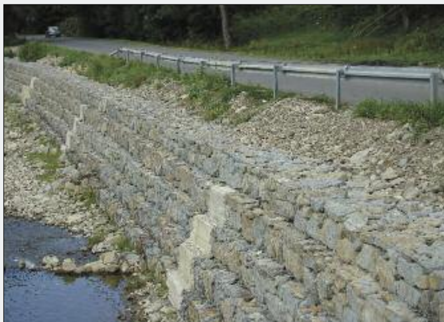
Umocnienia skarpy drogowej Soła
