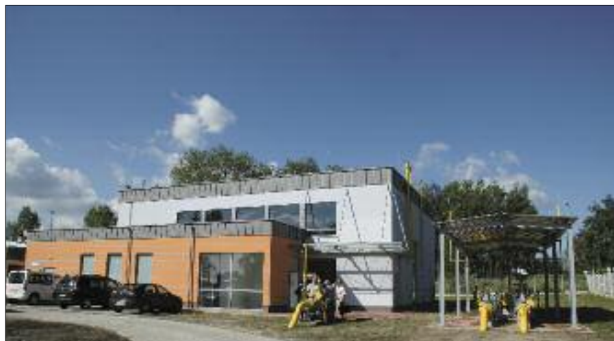
Stacja Kraków–Zawiła po modernizacji
