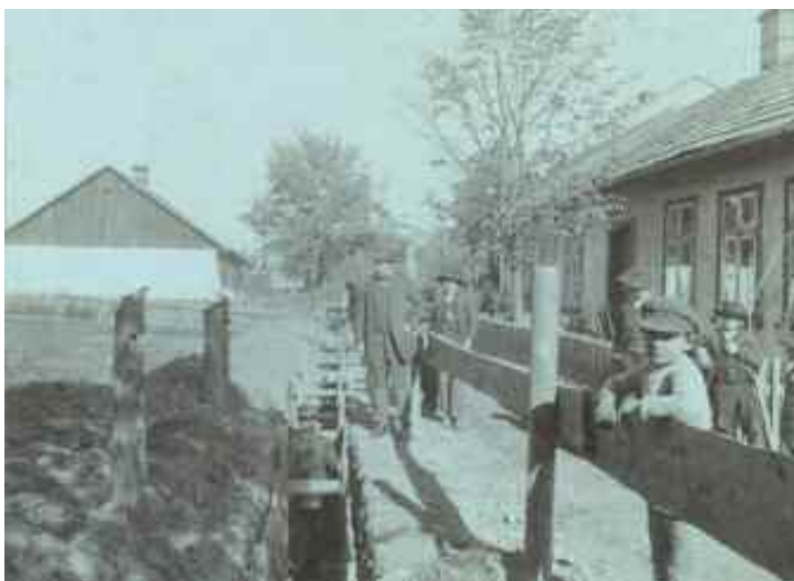
Odbiór magistrali wodociągowej przez inżynierów i przedstawiciela cesarza Franciszka Jozefa (w wykopie) 1911 r.
