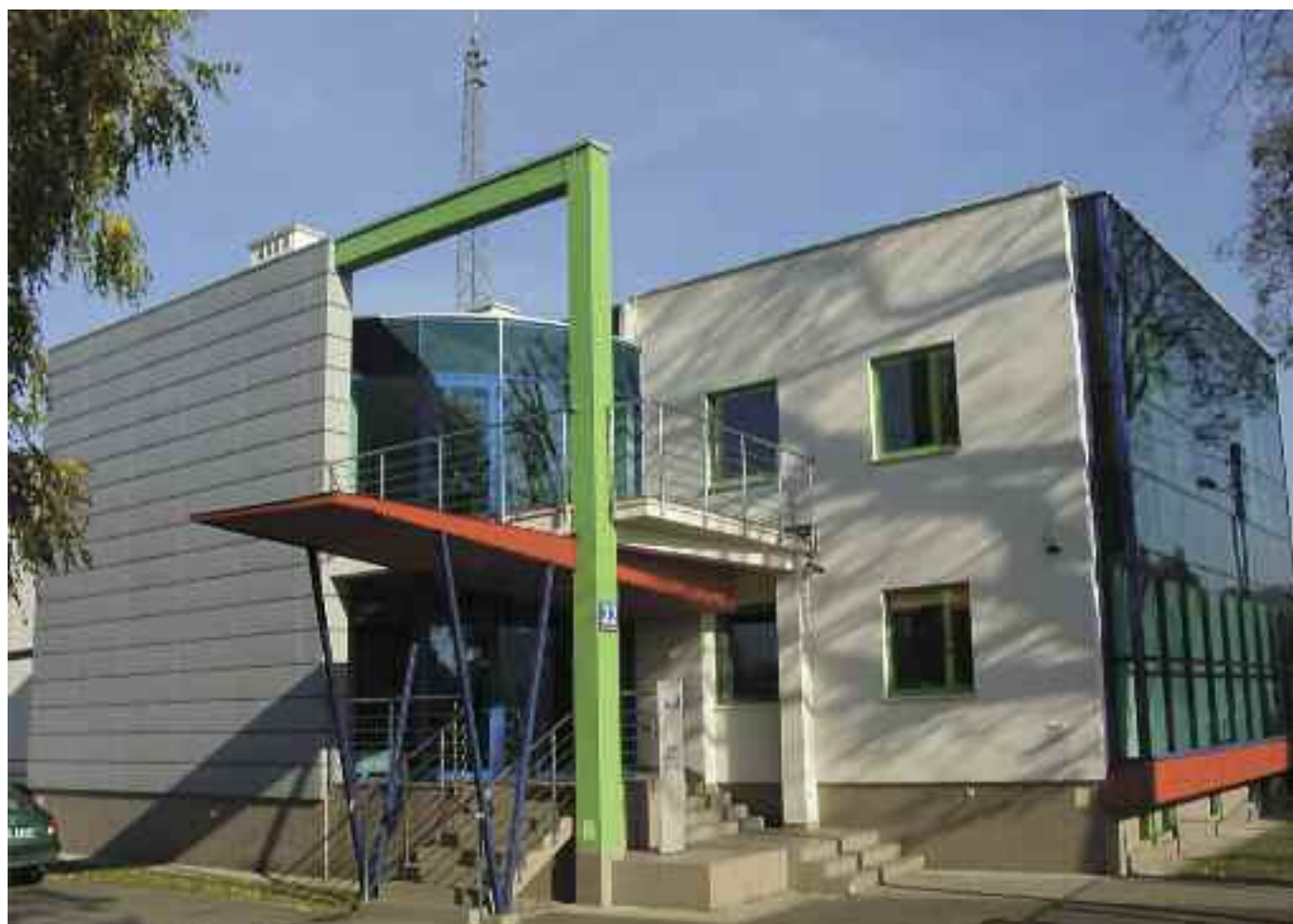
Siedziba Spółki „Wodociągi Sądeckie” w Nowym Sączu
