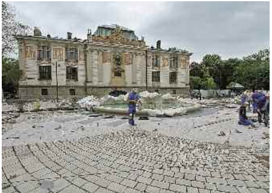
Plac Szczepański w trakcie przebudowy
