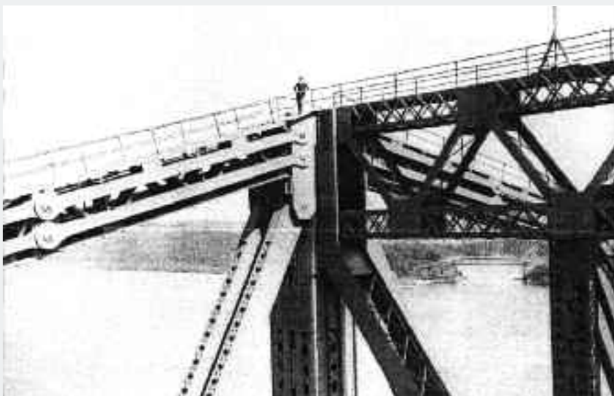
Olbrzymie wymiary belek ilustruje detal górnego węzła mostu z mężczyzną stojącym na najwyższym punkcie
