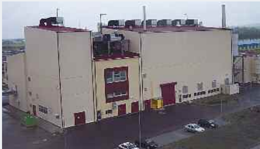
STUO – OD LEWEJ: WYDZIAŁ WĘZŁA PODSUSZANIA OSADÓW, WYDZIAŁ TECHNOLOGICZNY, WYDZIAŁ WĘZŁA TERMICZNEJ UTYLIZACJI OSADÓW
