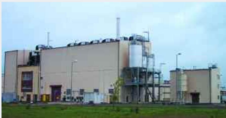
STUO – WIDOK NA WYDZIAŁ WĘZŁA TERMICZNEJ UTYLIZACJI OSADÓW (ŚRODEK ZDJĘCIA) I WYDZIAŁ WĘZŁA ZESTALANIA ODPADÓW (PRAWA STRONA)
