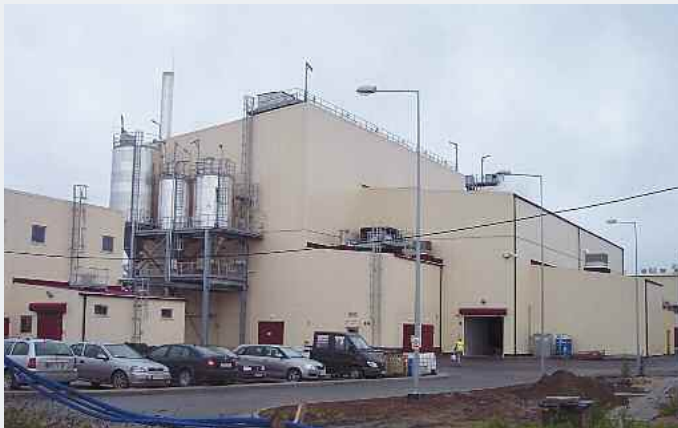
STUO – WIDOK NA MAGAZYN OSADU WRAZ Z POMIESZCZENIAMI WĘZŁA DEODORYZACJI ORAZ SILOSY POPIOŁU I POZOSTAŁOŚCI POPROCESOWYCH
