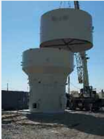
MONTAŻ PIECA FLUIDALNEGO
