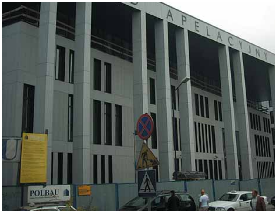
II etap budowy Sądu Apelacyjnego w Krakowie
