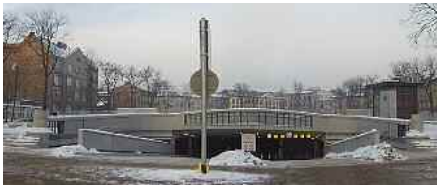
Wjazd i wyjazd od strony ul. Powiśle. Fot. Aleksandra Bąk
