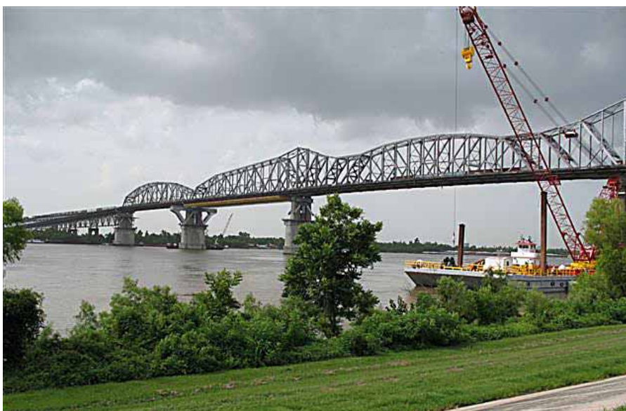
Przebudowa mostu w Nowym Orleanie – lipiec 2008 r.
