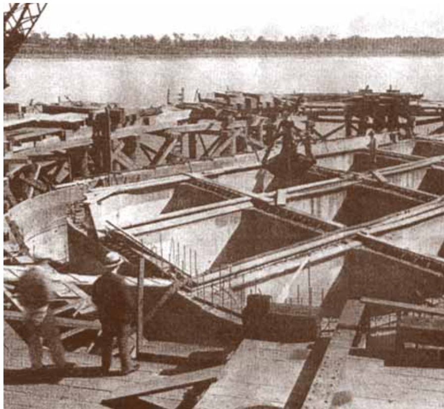
Archiwalne zdjęcia budowy kesonu podpory mostu – 1933 rok
