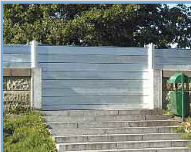
Ryc. 5 – Fragment murów przeciwpowodziowych z zamontowanymi ściankami szczelnym
