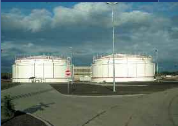
Zbiorniki - Terminal Paliwowy - Huta Szczecin
