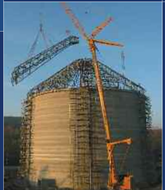
Cementownia Małogoszcz - Silos
