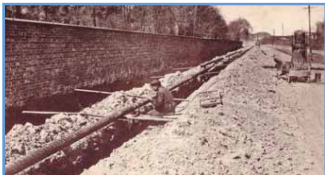
Budowa gazociągu wysokoprężnego - 1930 r.
