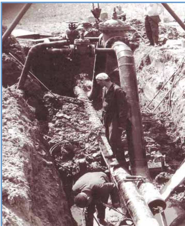
Budowa gazociągu w latach 70.
