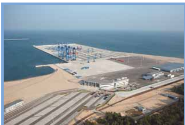
Głębokowodny Terminal Kontenerowy w Porcie Północnym
