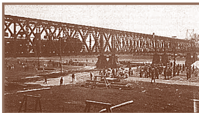
Fot. 4. Most na Wiśle w 1938 roku (zbudowany w 1884 roku)
