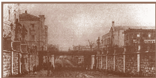
Fot. 6. Wiadukt nad ul. Lubicz w Krakowie
