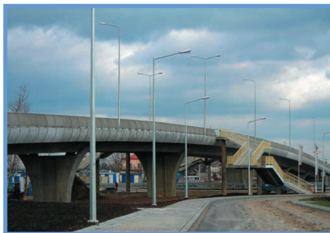
Wiadukt drogowy w Stalowej Woli - realizacja Mota Engil
