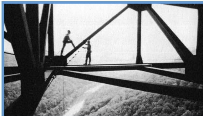
Inspektorzy w trakcie przeglądu stanu technicznego kratownic mostowych
