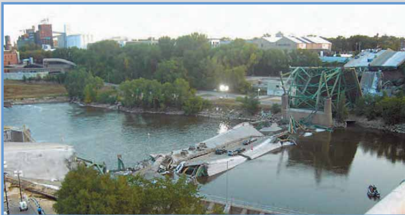
Most po katastrofie. Widok od strony południowo-wschodniej
