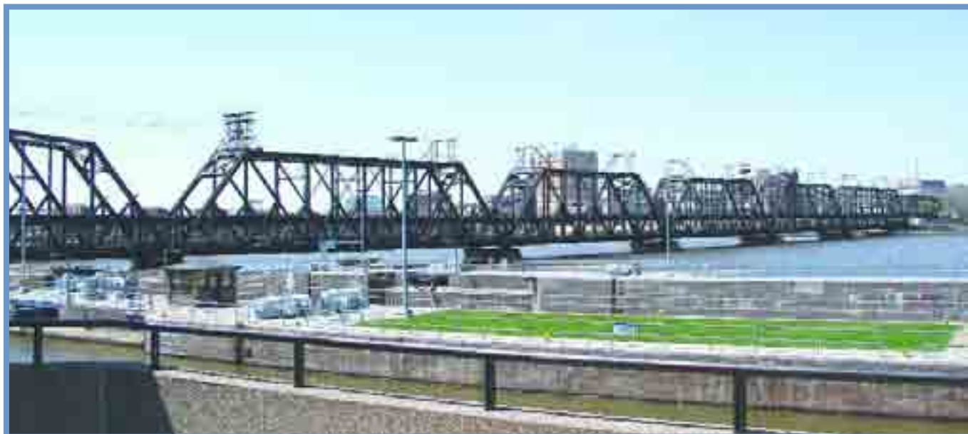
Widok ogólny mostu w Rock Island
