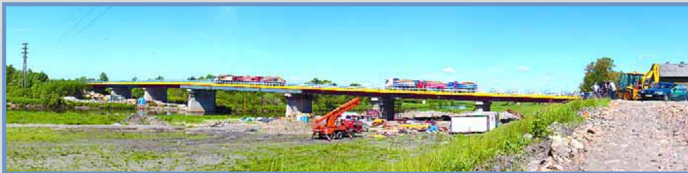
Próbne obciążenie mostu.
