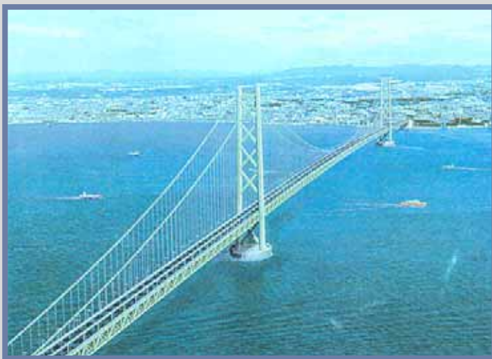
Ogólny widok mostu
