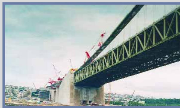
Widok przyczółka od strony Kobe (w czasie budowy - autor Zygmunt Rawicki)
