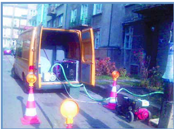
Napełnianie sieci gazowej – ul. Bydgoska październik 2005 r.
