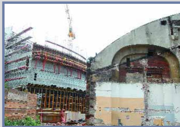
Budowa Opery w Krakowie
