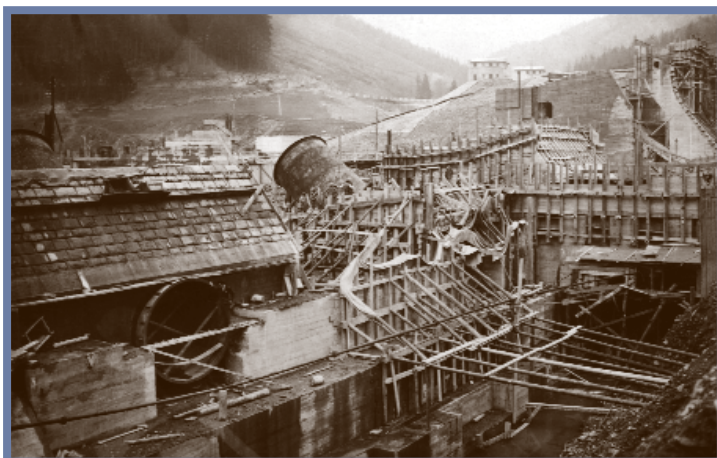
Porąbka - zakładanie rur dla elektrowni wodnej
