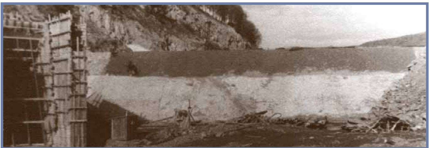
Tresna - II etap nasypu i wlot do sztolni
