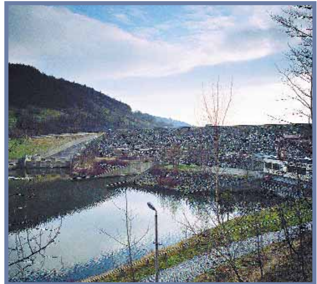
Zapora w Tresnej
