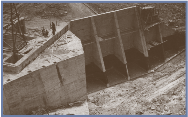
Tresna - blok i ściana oporowa na usuwisku
