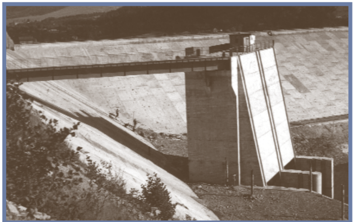
Tresna - wieża zamknięć wlotów do sztolni energetycznej
