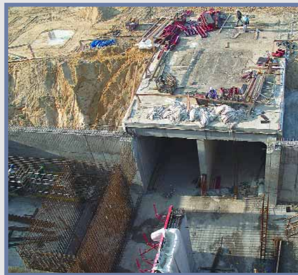
Rys. 3 Część wlotowa do tunelu tramwajowego przy krawędzi zachodniej dworca kolejowego (fot. K. Ryż.)
