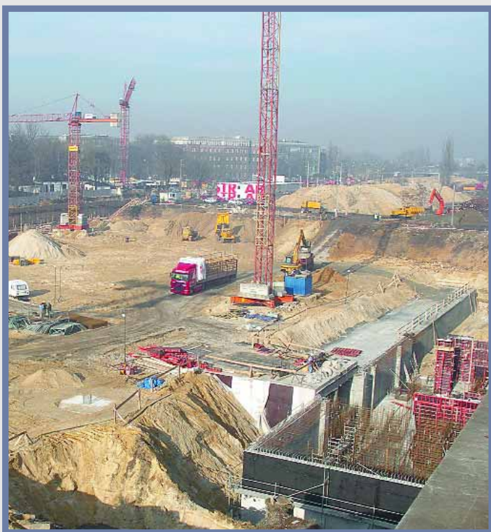
Rys. 2 Budowa tunelu Krakowskiego Szybkiego Tramwaju pod obiektami kubaturowymi Galerii Krakowskiej (strona zachodnia KCK), (fot. K. Ryż.)
