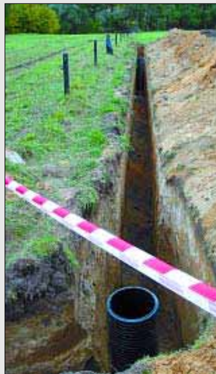
Gdyby wykop podparto chociaż deskami szalunkowymi, to może dzisiaj żyłby pracujący tam mężczyzna
