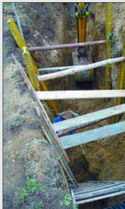
Gdyby wykop podparto chociaż deskami szalunkowymi, to może dzisiaj żyłby pracujący tam mężczyzna
