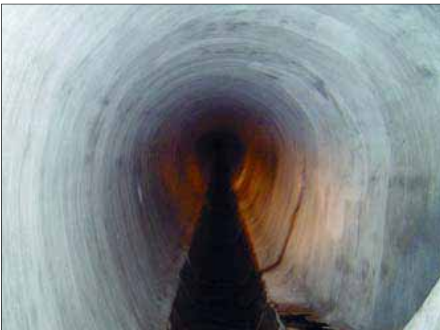
Kanał po remoncie metodą wykładania
