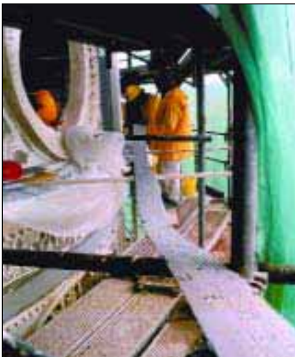
Wzmacnienie konstrukcji kaplicy na Zamku w Kraszycynie
