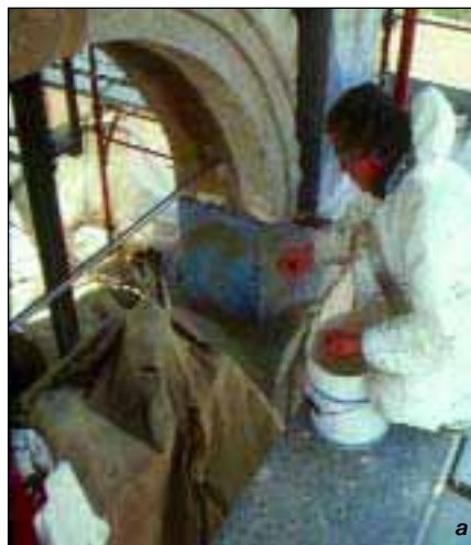
Przykłady wzmocnienia obiektów sakralnych systemem Sika CarboDur w różnych krajach europejskich: a) Włochy b) Bośnia i Hercegowina
