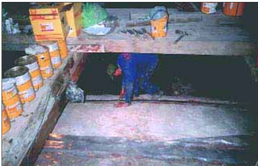
Wzmocnienia taśmami kompozytowymi z włókien węglowych Sika CarboDur ceglanego sklepienia kolebkowego w kościele św. św. Piotra i Pawła w Krakowie w 1999 roku.
