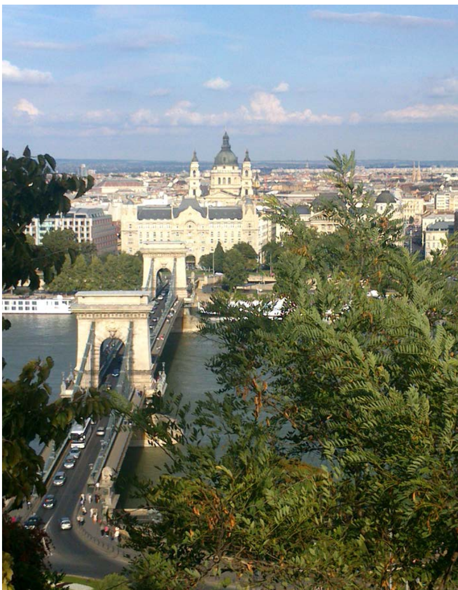
Budapeszt - widok z zamku Habsburgów na Most Łańcuchowy im. hr. Széchenyiego (1849, proj. inż. W.T. Clark, wyk. inż. A. Clark) i Peszt, fot. M.A. Urbańska
