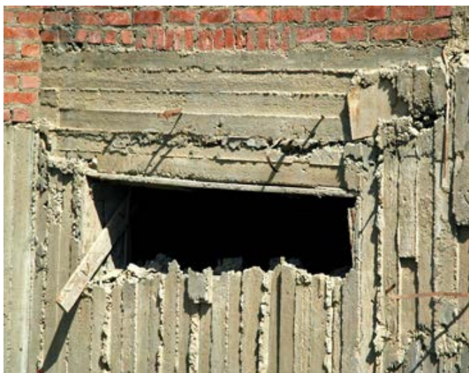
Fot. 4. Sharm el Sheikh – fragment żelbetowej ściany po rozszalowaniu
