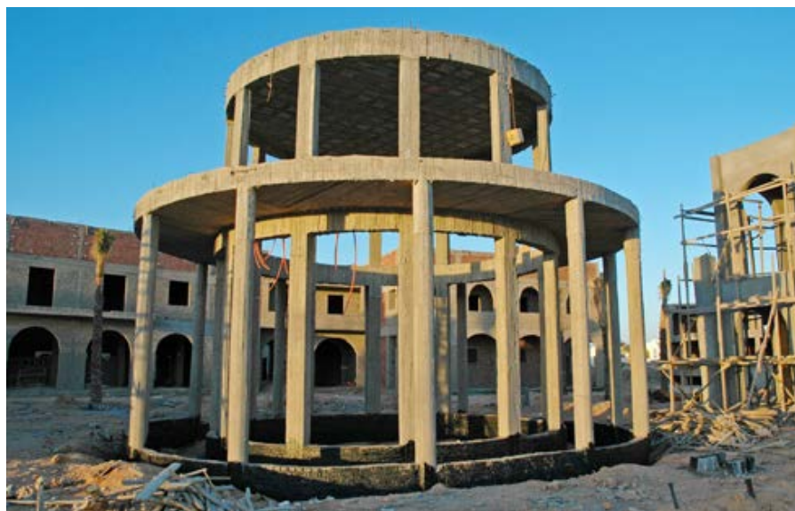
Fot. 1. Sharm el Sheikh w Egipcie – budowa kolejnego hotelu
