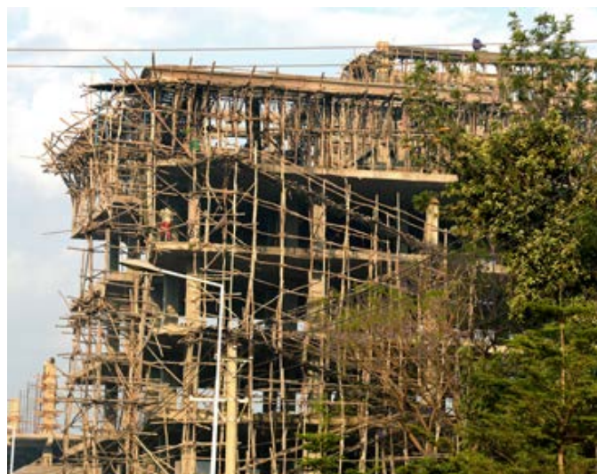
Fot. 9. Bahar Dar w Etiopii – budowa wielokondygnacyjnego budynku szkieletowego
