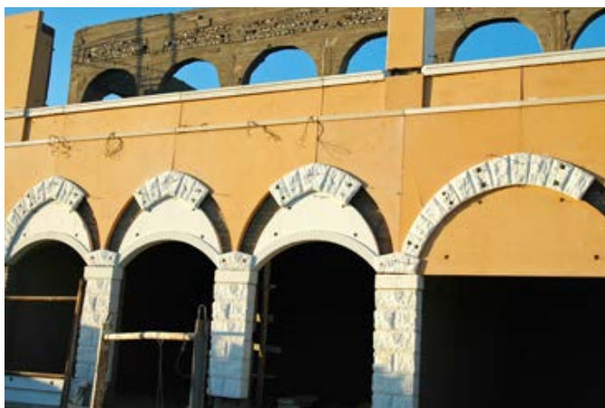
Fot. 6. Sharm el Sheikh – prace elewacyjne na budowie hotelu
