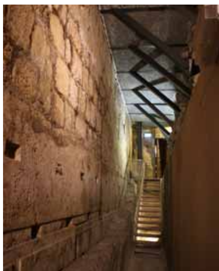
Widok podwalin Ściany Płaczu i podparć ulicy w tym rejonie.
