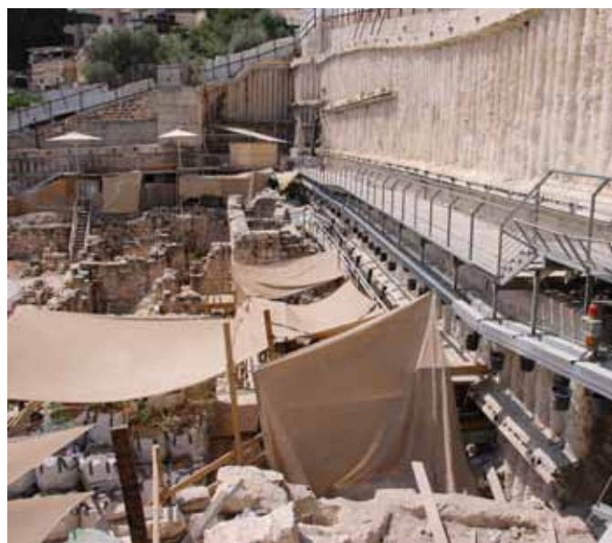
Widok zabezpieczenia ściany wykopu systemem palowania i późniejszej odkrywki. Zabezpieczenie zbocza.
