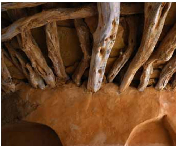
Fot. 13. Ksar Ouled Soltane – fragment płaskiego stropu z drewnianych pni i konarów
