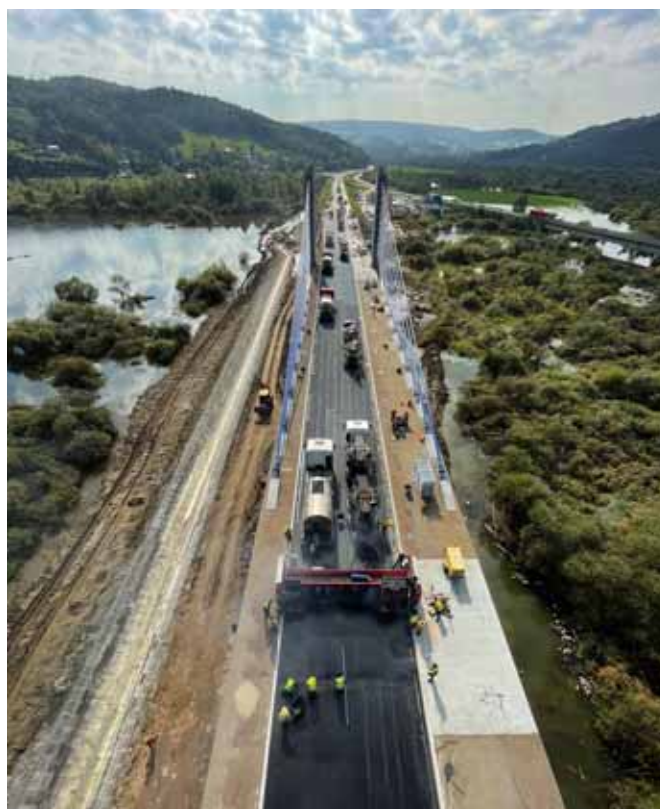
Wykonywanie warstwy wiążącej z asfaltu twardolanego
