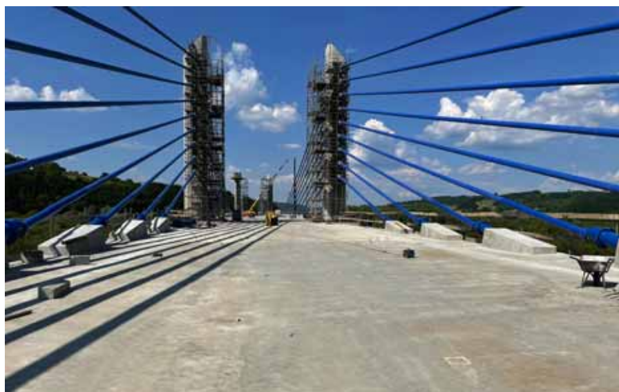
Budowa pylonów i realizacja podwieszenia
