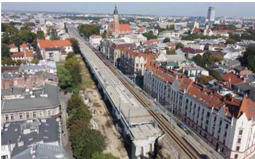
Estakada Kraków, fot. Piotr Hamarnik
