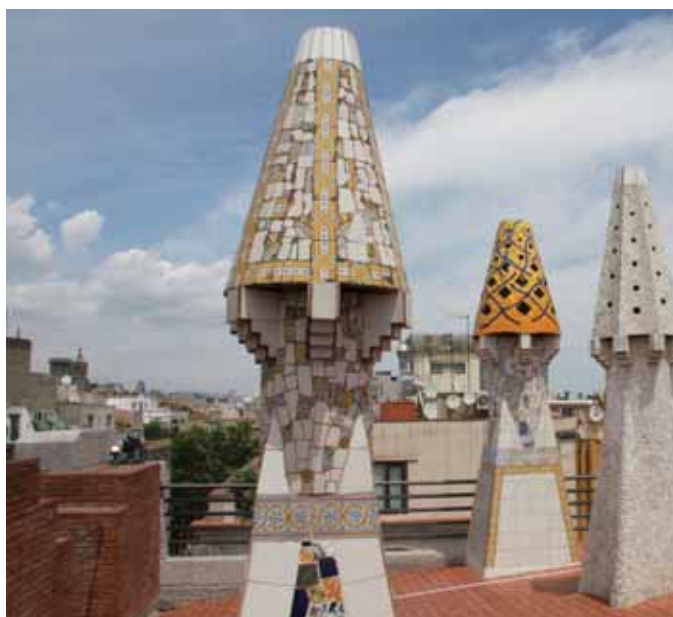
Mozaika na kominach wentylacyjnych budynku zaprojektowanego przez Gaudiego. Barcelona. Hiszpania.
