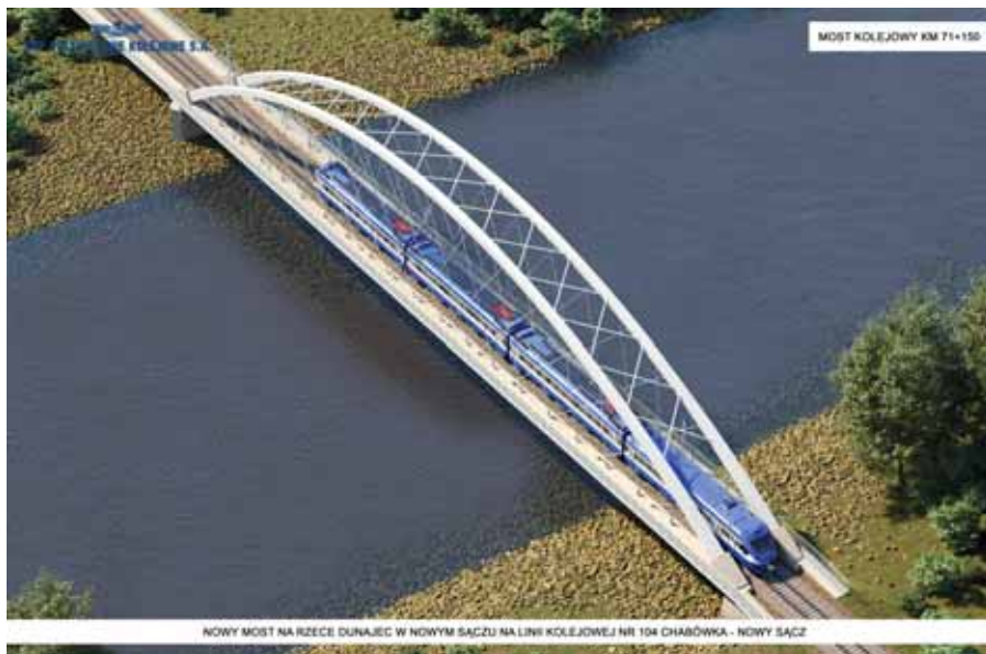
Linia kolejowa 104 Odcinek E – przeszło nurtowe mostu kolejowego na rzece Dunajec w Nowym Sączu w km proj. 71+150 z lotu ptaka
