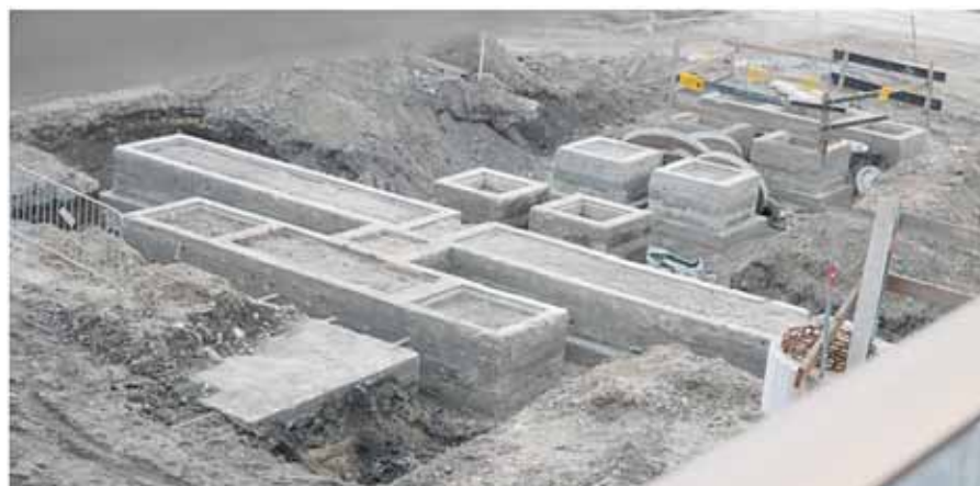
Fot.1. Widok ogólny studzienek dawnej komory filtrów.
