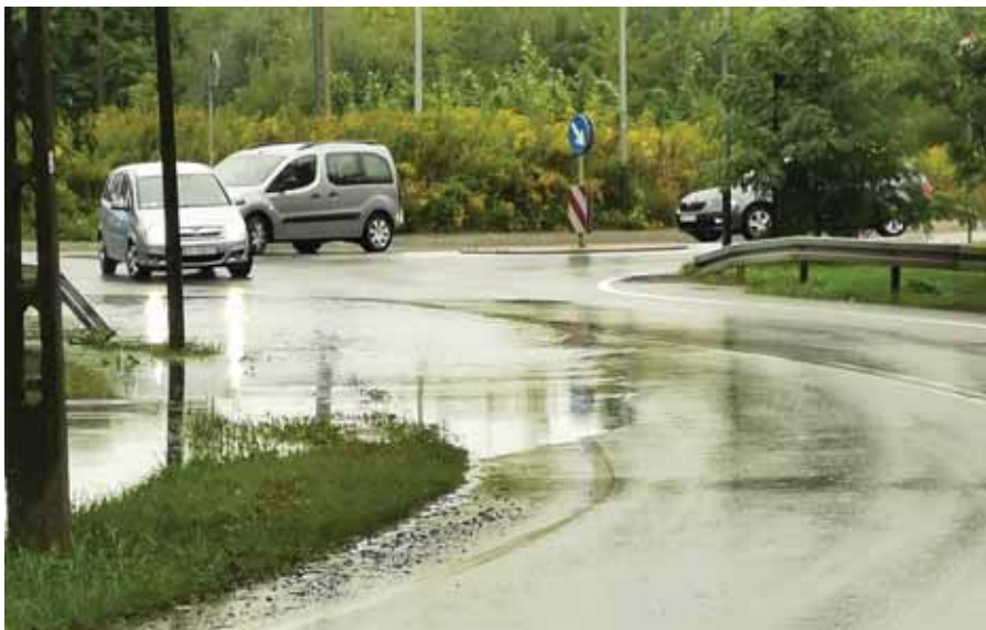
Fot. 1. Lokalne podtopienia ulic w Krakowie spowodowane wystąpieniem deszczu nawałnego
