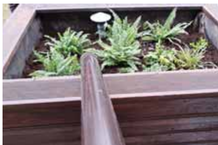
Fot. 6. Ogród deszczowy
