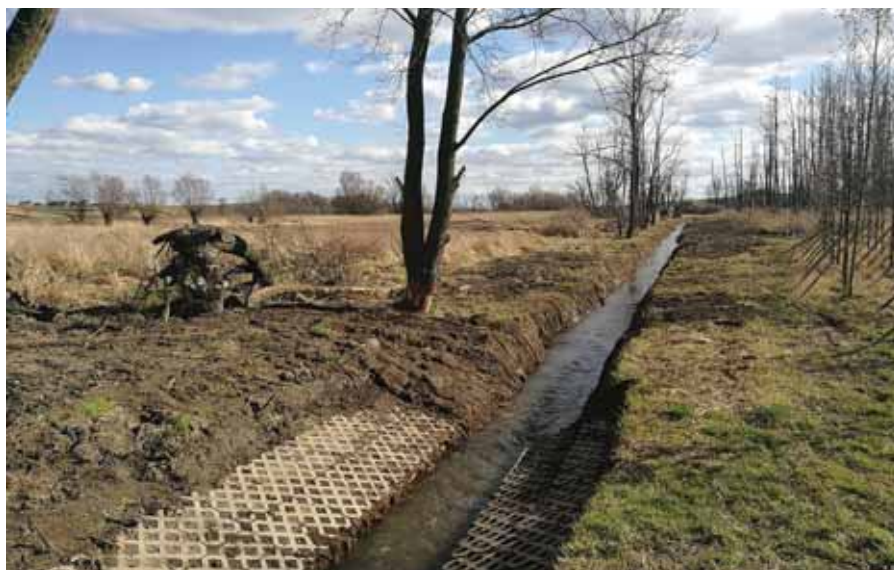
Fot 4. Rów odwodnieniowy
