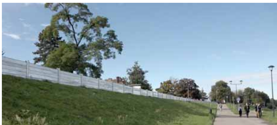
Fot. 2. Mobilny system przeciwpowodziowy
