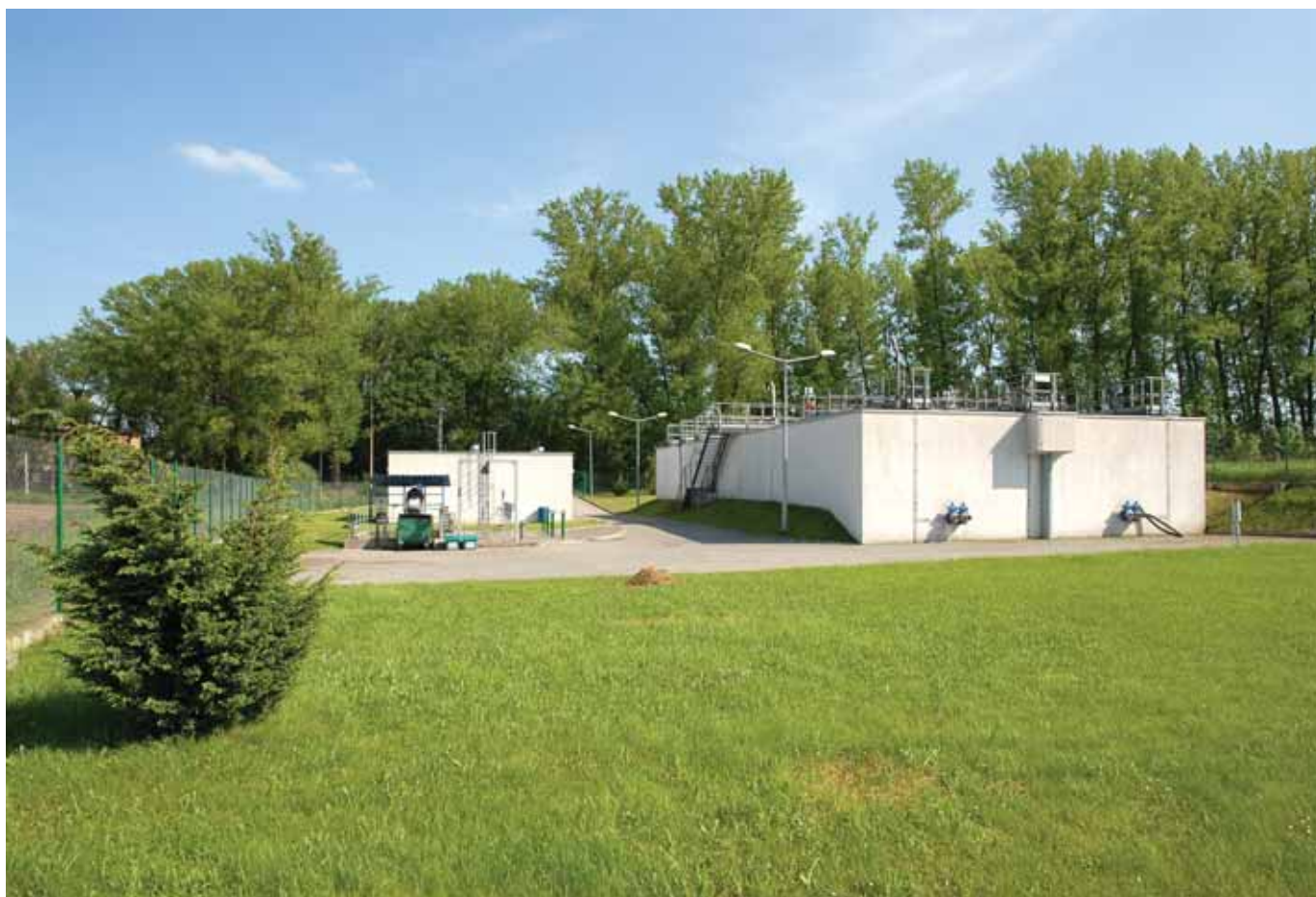
Mała oczyszczalnia ścieków w Wadowie
