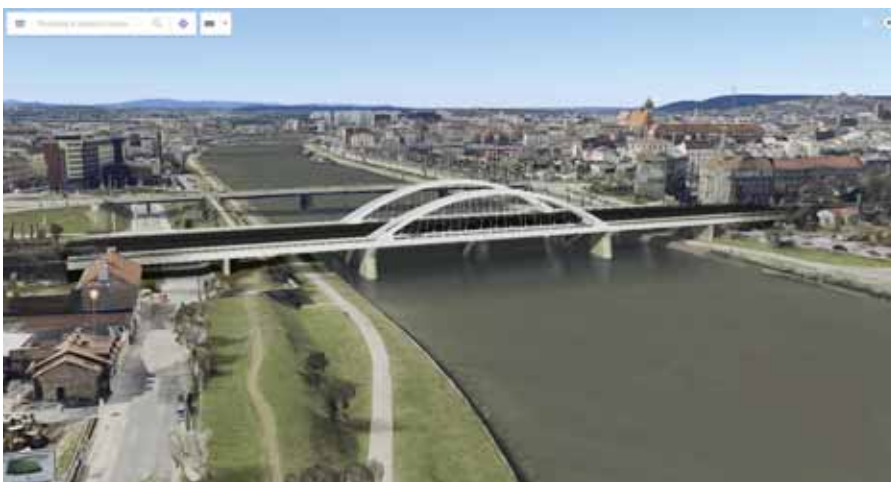
Rys.2. Wizualizacja przedstawiająca pierwotny projekt - Konstrukcja stalowa 6-przęsłowa nitowana i spawana - remont. Dobudowa dwóch równoległych konstrukcji linii aglomeracyjnej 5-przęsłowych z łukiem w przęśle środkowym. (BBF/BPK Mosty)
