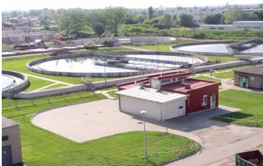
Fragment oczyszczalni ścieków – osadniki radialne
