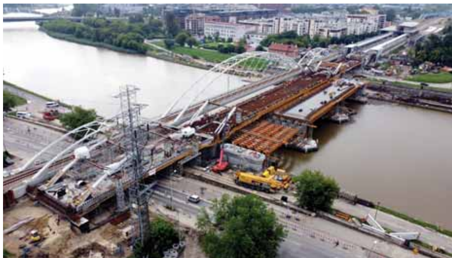
Fot.2. Zaawansowanie prac przy budowie mostów przez Wisłę – sierpień 2021 r.
