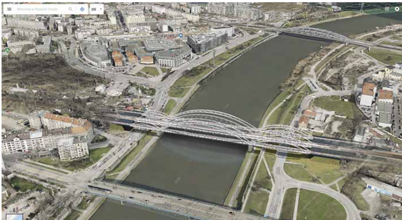
Rys.4. Wizualizacja przedstawiająca nowy projekt - Trzy równoległe mosty kolejowe trójprzęsłowe łukowe siatkowe ze środkowymi przęsłami przekraczającymi koryto Wisły. (koncepcja: Bogusław Pilujski, STRABAG)
