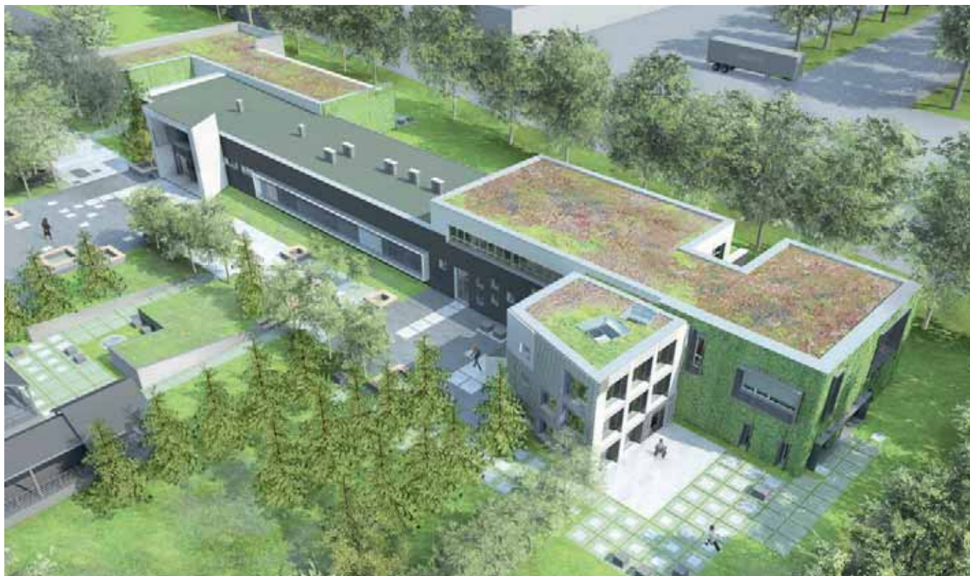
Wydział Inżynierii Produkcji i Energetyki Uniwersytetu Rolniczego w Krakowie (projekt w realizacji). Architektura Pasywna Pyszczek i Stelmach sp.j. W celu ograniczeniu strat ciepła zaprojektowany budynek ma formę zwartej bryły. Proponowane rozwiązania projektowe spełniają szereg wymogów związanych z oceną wielokryterialną typową dla zrównoważonych, zielonych inwestycji takich jak: zrównoważenie w ramach zagospodarowania terenu, ograniczenie zużycia wody, ograniczenie zużycia energii poprzez zastosowanie energii odnawialnych oraz zapewnienie jakości środowiska wewnętrznego.
