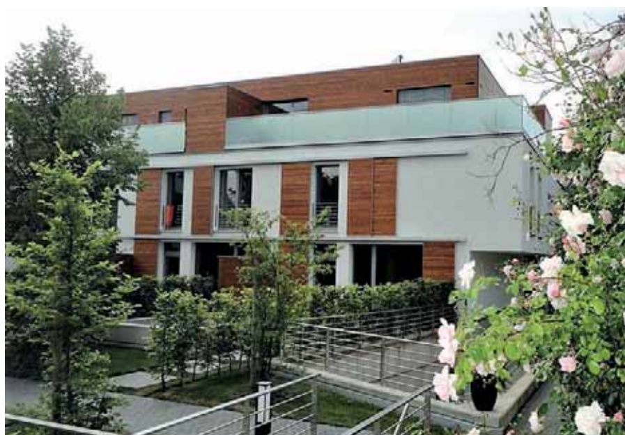
Budynek wielorodzinny w standardzie pasywnym, dach zielony na garażu podziemnym, projekt zespołowy arch. Kamil Wiśniewski, Rongen Architekten GmbH. Akademia Zdrowego Budownictwa
