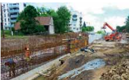
Przebudowa potoku Sudoł (rejon ul. Opolskiej)
