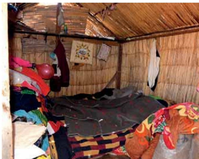
Fot. 10. Wnętrze domku, widoczna drewniana konstrukcja nośna
