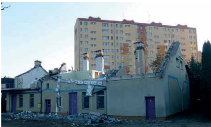
Burzenie budynków przy ul. Białoprądnickiej (pierwsze prace rozbiórkowe (jesień 2020)
