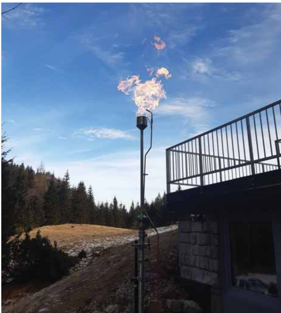
Fot.1 Gaz spalany na kolumnie w czasie zagazowywania sieci zasilającej m.in. Hotel Górski PTTK Kalatówki
