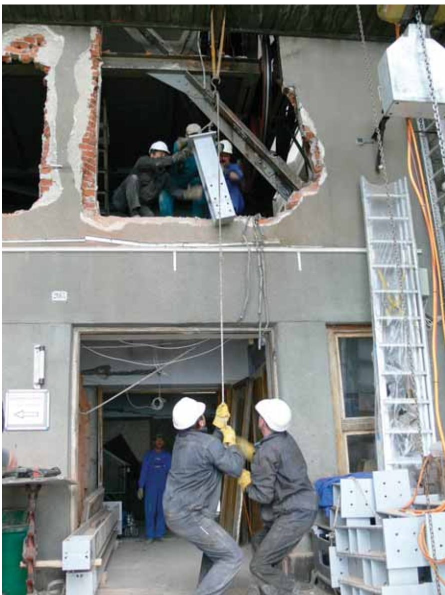
Fot. 7. Montaż konstrukcji wsporczej pod łożyska liny nośnej na stacji Kasprowy Wierch
