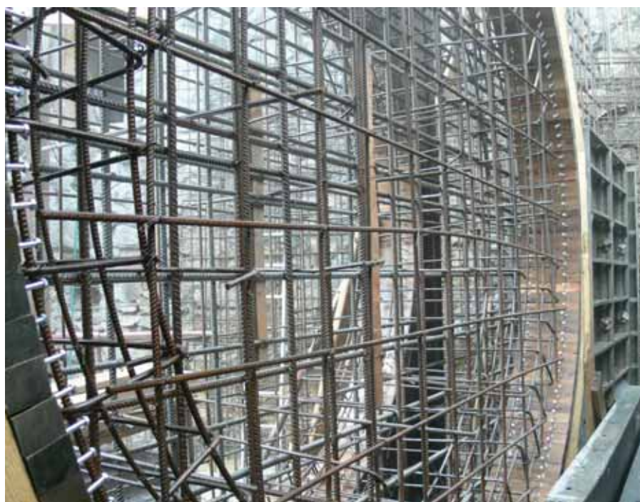
Fot. 6. Zbrojenie bębna kotwiącego liny nośnej
