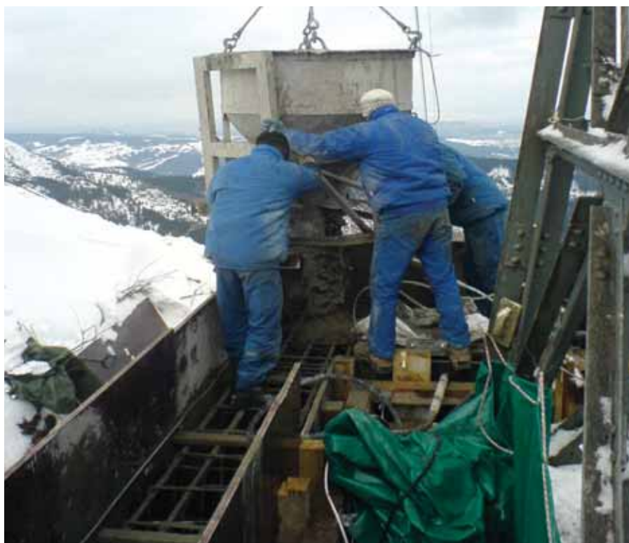
Fot. 2. Betonowanie wieńca fundamentu konstrukcji podpory nr 5
