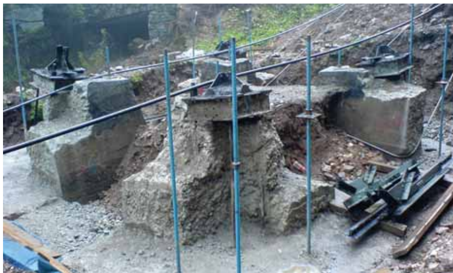
Fot. 4. Mikropale w fundamencie podpory nr 1
