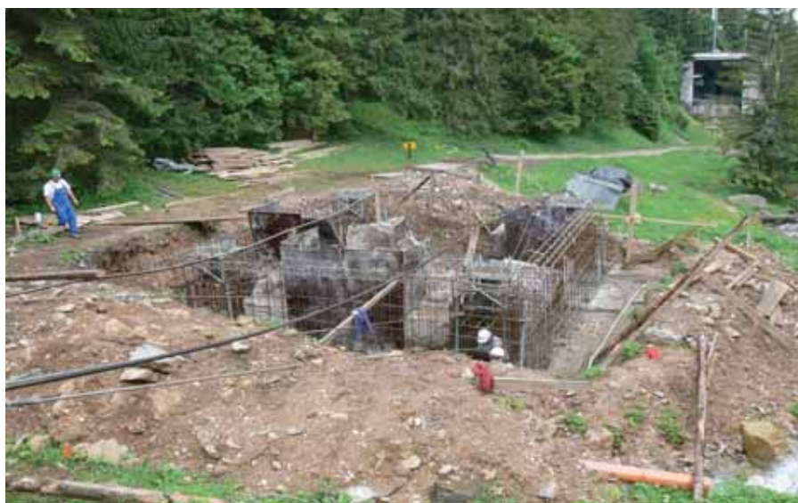
Fot. 1. Wykonywanie zbrojenia fundamentu podpory nr 1
