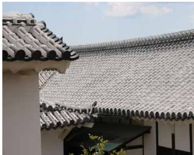
Zabezpieczenie przeciwogniowe dachu
