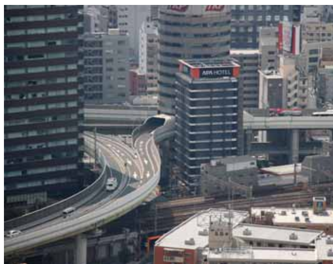
Autostrada przechodzi przez budynek w Osace
