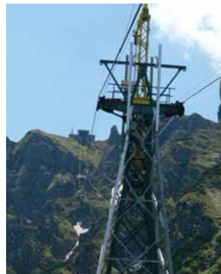
Fot. 5. Montaż nowej konstrukcji podpory przy użyciu podnośnika
