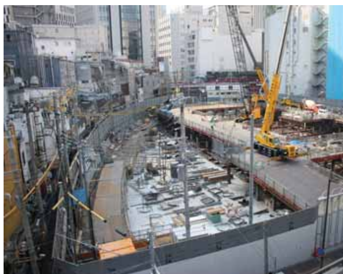
Plac budowy w centrum miasta
