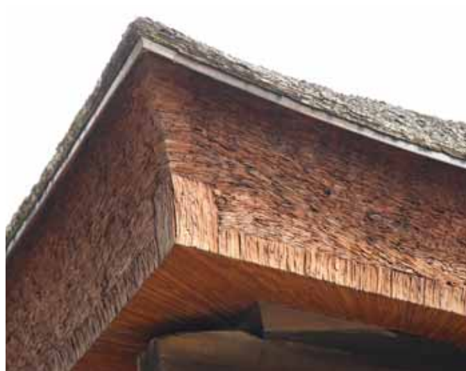
Perfekcyjnie wykonane pokrycie
