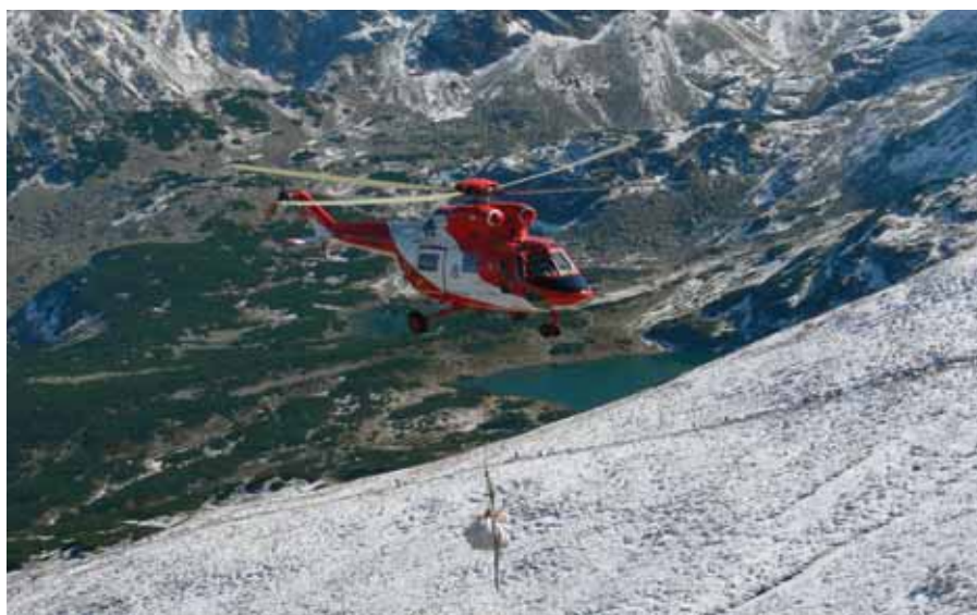
Fot. 3. Transport materiałów budowlanych śmigłowcem TOPR
