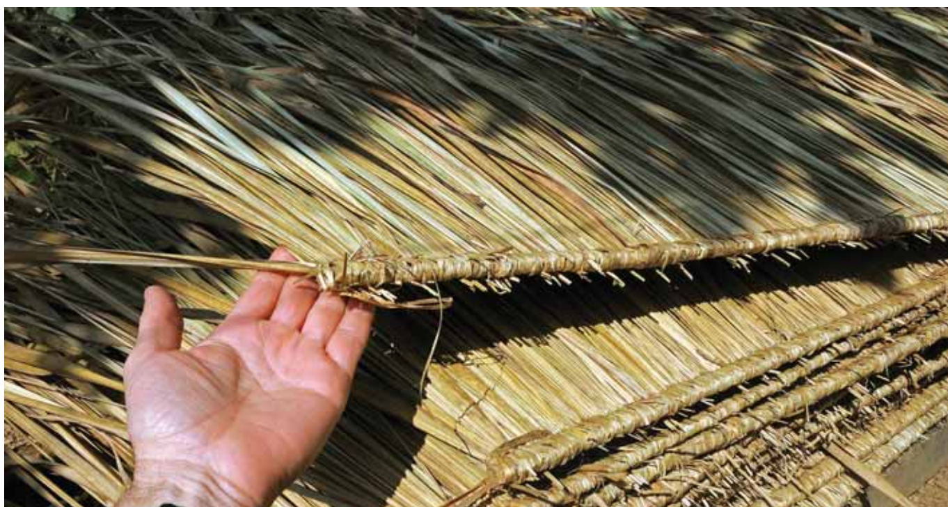
Fot. 6. Plecionka z traw na listwie bambusowej – gotowy element na pokrycie dachu
