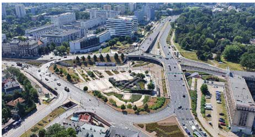
Węzeł przesiadkowy i komunikacyjny Rondo Mogiłskie
