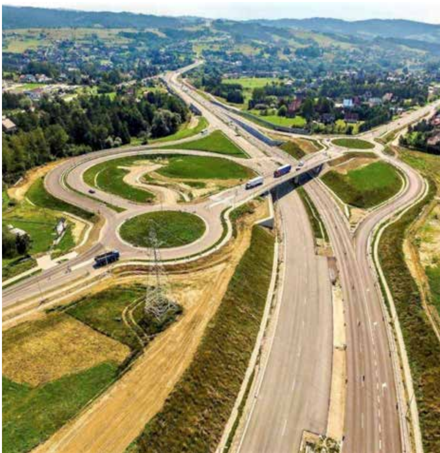
Budowa Zakopianki – Węzeł Zabornia
