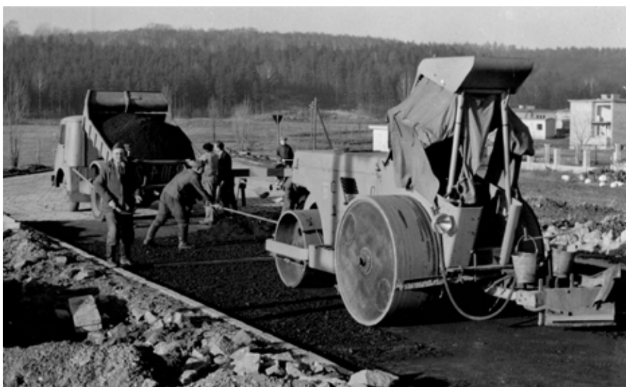
Układanie warstw podbudowy i mas bitumicznych
