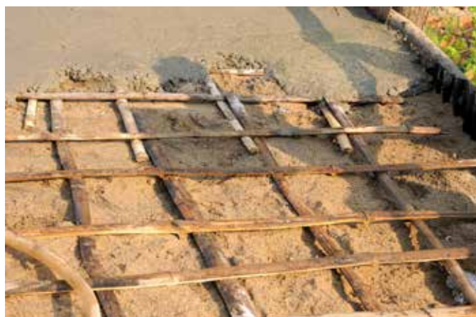
Fot. 15. Phnom Penh – betonowa nawierzchnia chodnika zbrojona listwami bambusowymi
