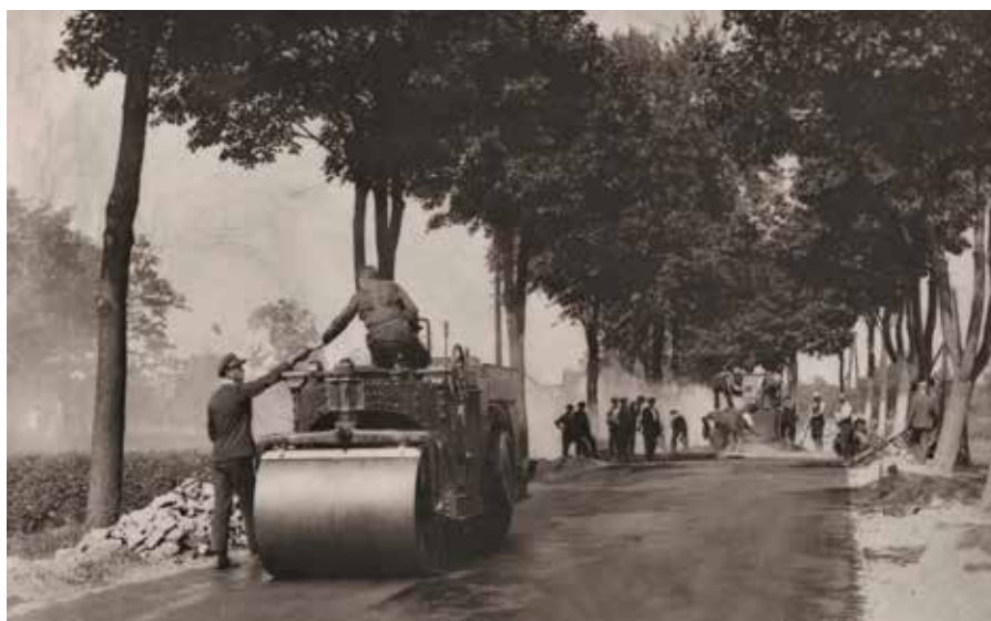
Najbardziej widowiskowym i niezbędnym sprzętem do układania warstw podbudowy i mas bitumicznych był i jest walec drogowy
