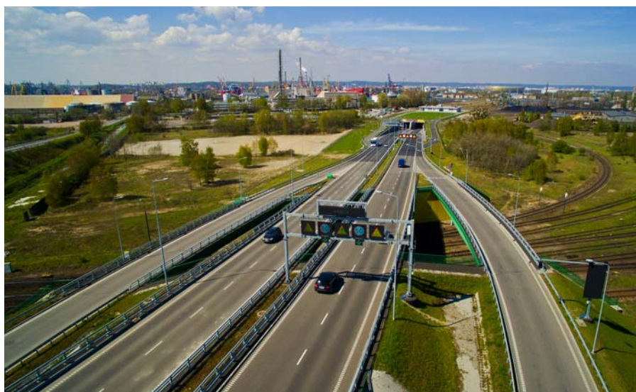
Trasa Słowackiego – widok na wjazd-wyjazd do-z tunelu od węzła Ku Ujściu
