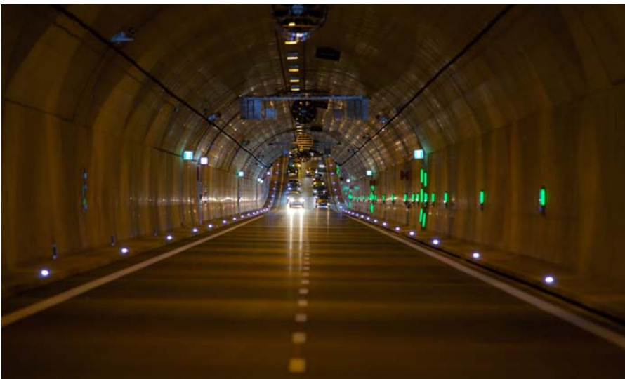
Tunel pod Martwą Wisłą
