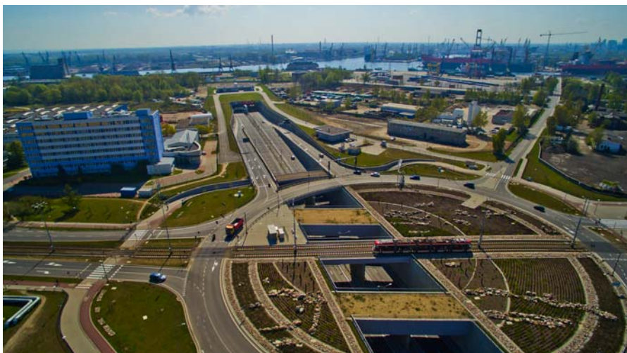
Węzeł Marynarki Polskiej – wjazd do tunelu
