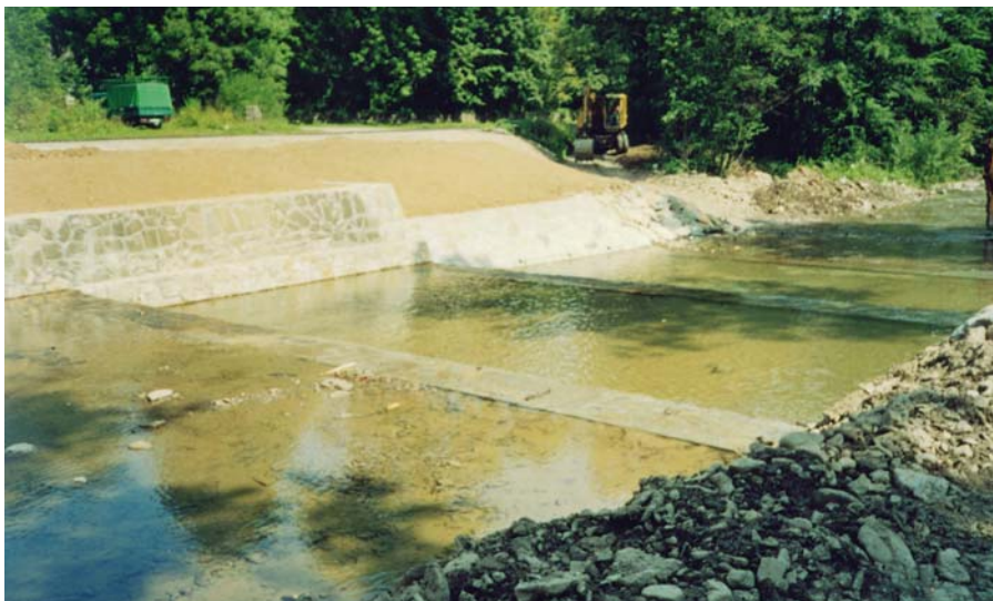
Odbudowane po powodzi stopnie wodne na potoku Porębianka w Porębie Wielkiej
