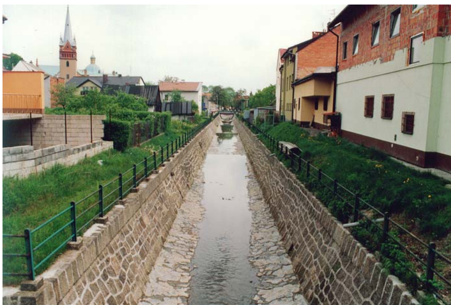
Potok Bysinka w Mysłenicach - usunięte szkody popowodziowe
