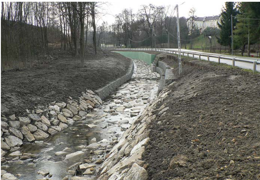
Potok Wątok, m. Skrzyszów zabezpieczenie drogi
