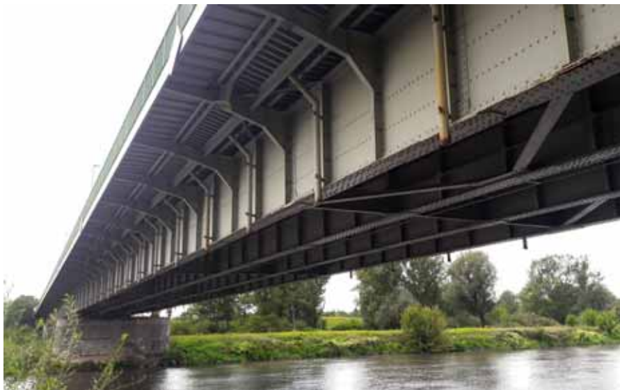
Fot. 8. Most w Łęgu przez Wisłę w Krakowie, fot. Andrzej Soborń
