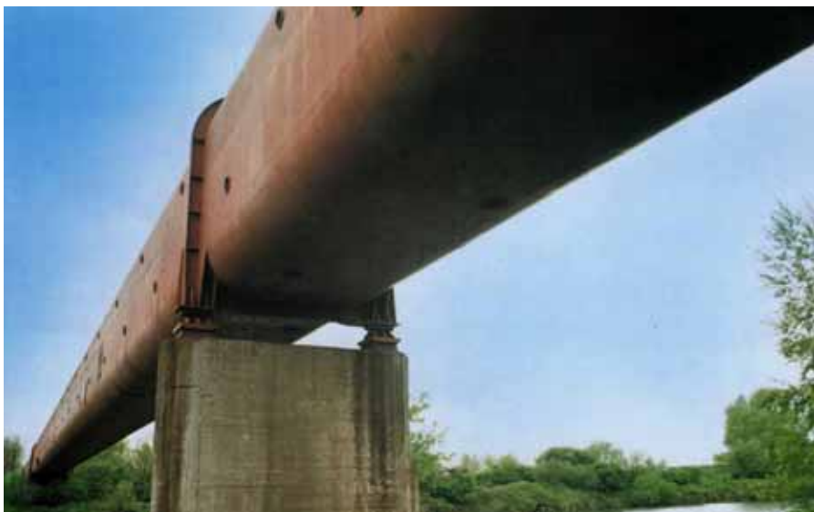
Fot. 2. Most technologiczny przez Wisłę w Łęgu, fot. Mostostal Kraków
