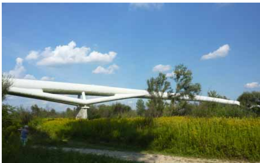
Fot. 3. Most technologiczny przez Dunajec w Nowym Sączu, fot. Andrzej Soborń
