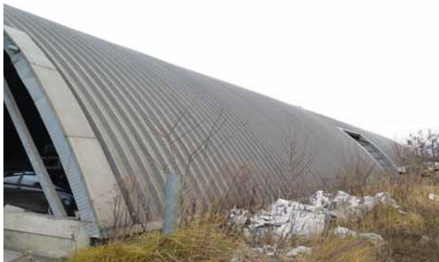
Rys. 3. Widok dachu z blach falde wykonanych w systemie ABM
