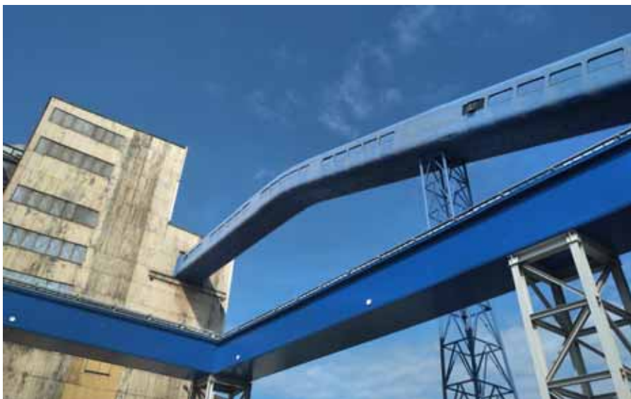
Fot. 1. Galeria powłokowa w Elektrociepłowni Łęg w Krakowie, fot. Mateusz Hodurek
