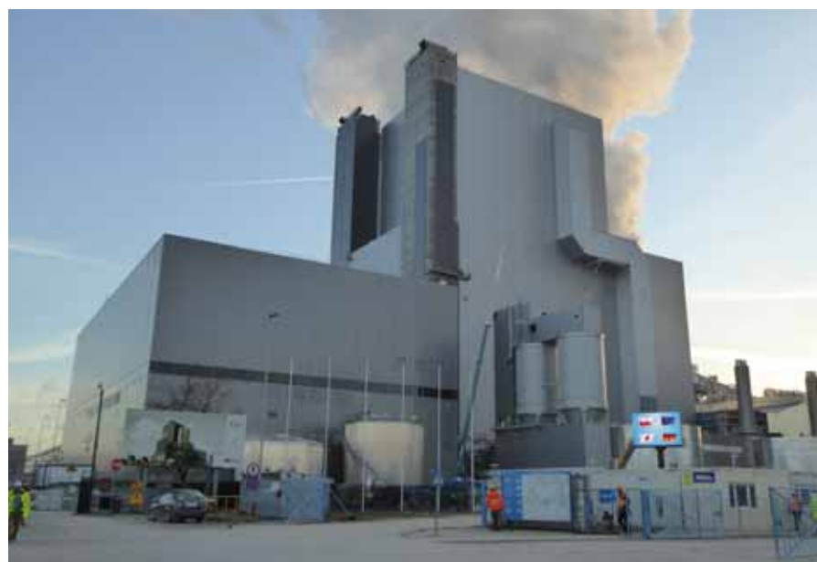
Obudowa bloku energetycznego w Jaworznie
