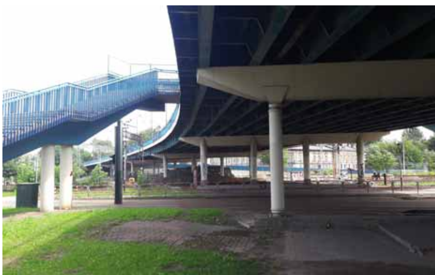
Fot. 9. Wiadukt drogowy nad torami kolejowymi w ul. 29 Listopada w Krakowie, fot. Andrzej Soborń
