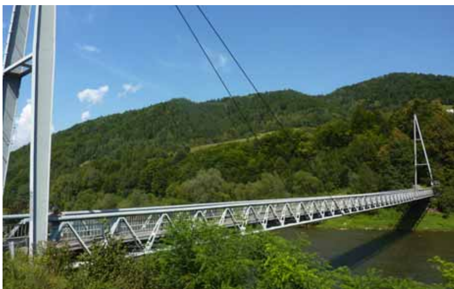
Fot. 11. Kładka przez Dunajec w Tylmanowej, fot. Andrzej Soboń
