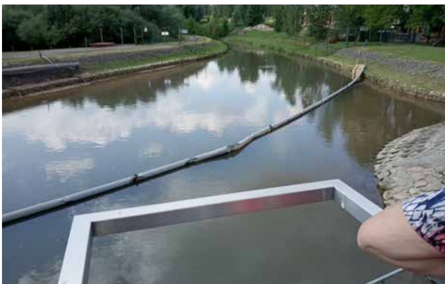
Pływająca zapora przeciwolejewą, zamontowana przed oknami wlotowymi ujęcia
