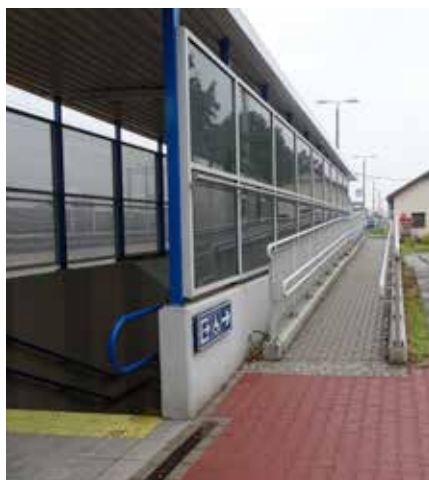
Nowe przejście podziemne na peron w stacji Podłęże
