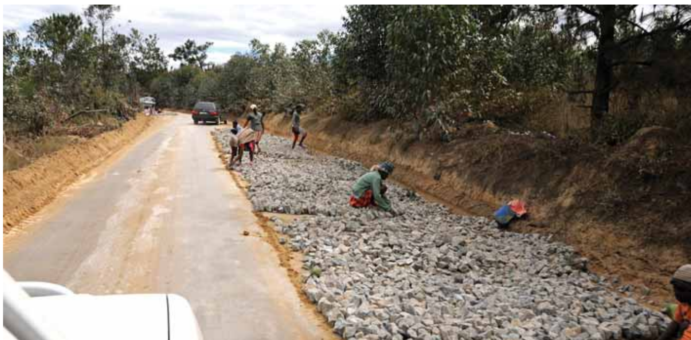
Fot. 25. Mieszkańcy wioski układają kamienną nawierzchnię drogi
