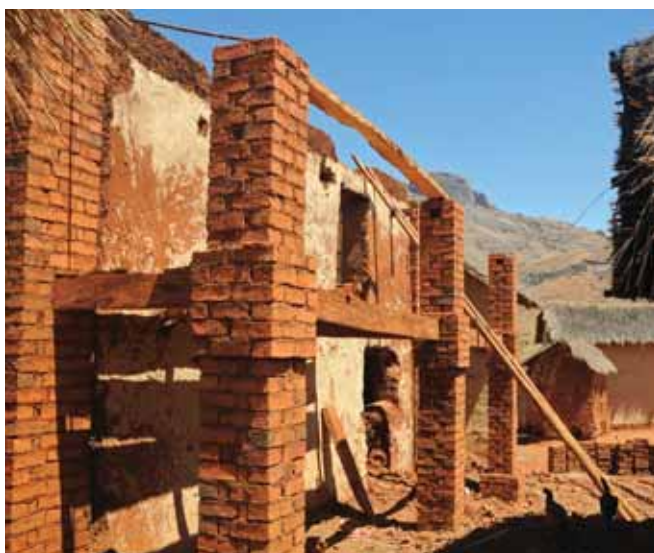
Fot. 18. Budowa domu z cegły niewypalanej (cegła zawdzięcza swą barwę kolorowi gliny)
