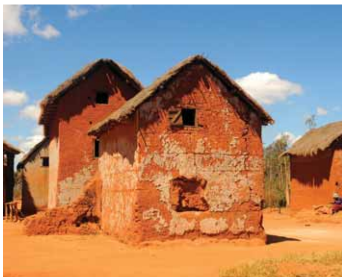
Fot. 19. Dwukondygnacyjne budynki z niewypalanej cegły
