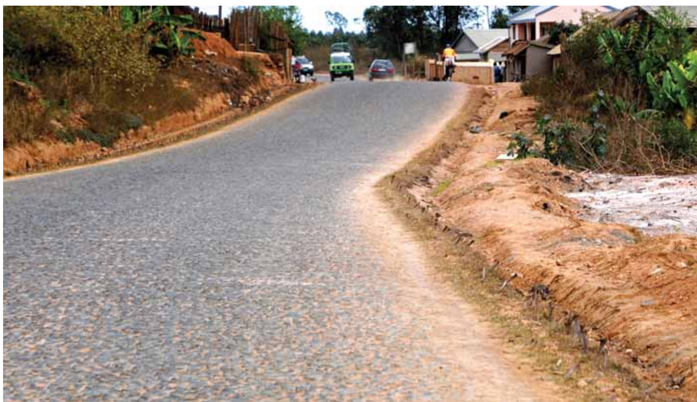
Fot. 26. Gotowa nawierzchnia kamienna
