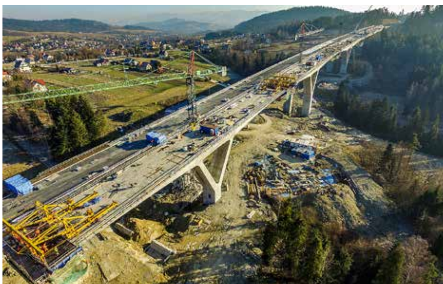
FOT. 11 Ob. 21-najdłuższy obiekt odc. III
