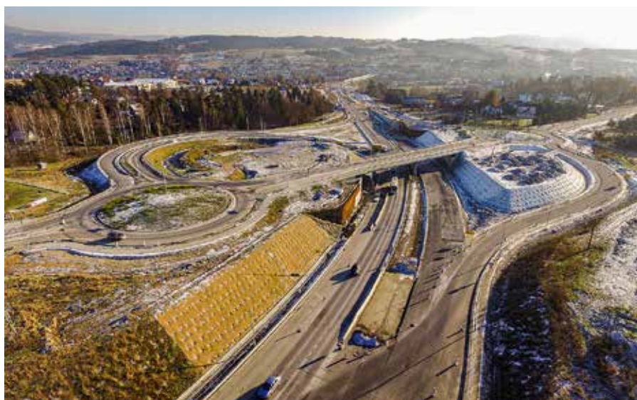
FOT. 12 Węzeł Zabornia
