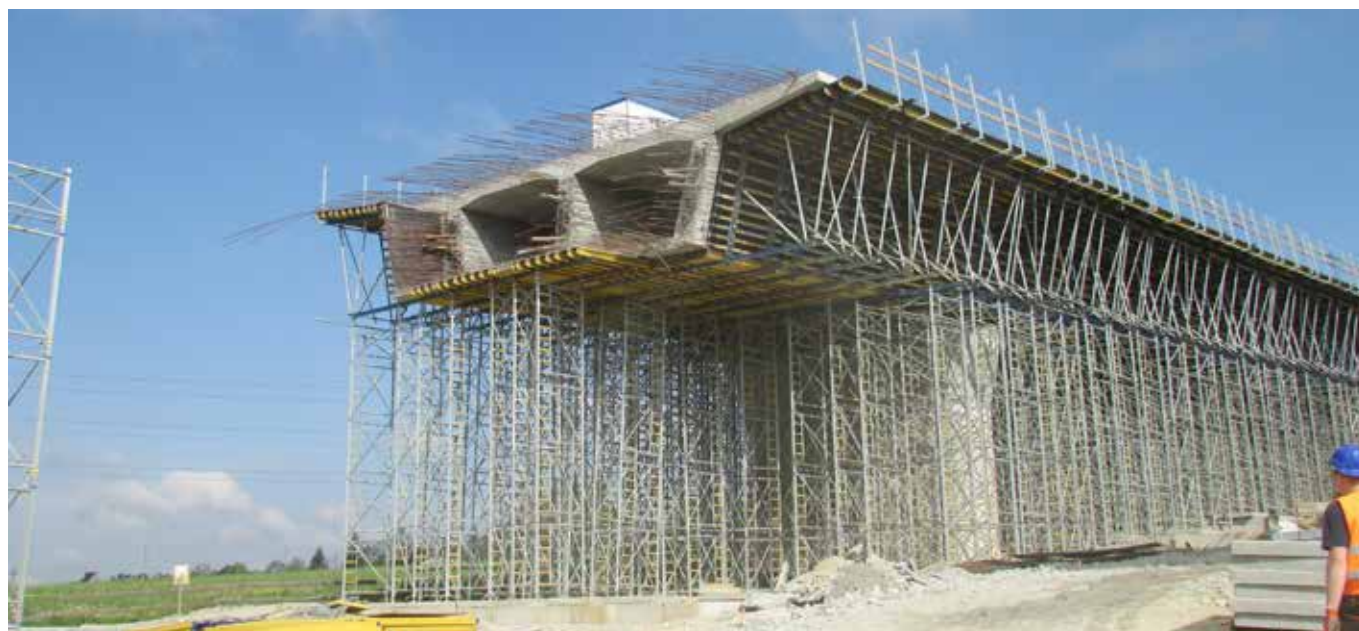
FOT. 7 Estakada odc. II
