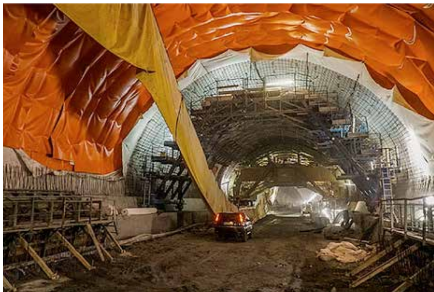
FOT. 5 Hydroizolacja zbrojenie kaloty
