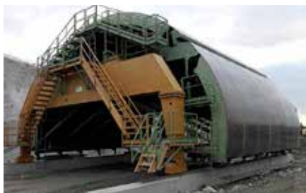
FOT. 3 Przekrój tunelu i samobieżny szalunek kaloty
