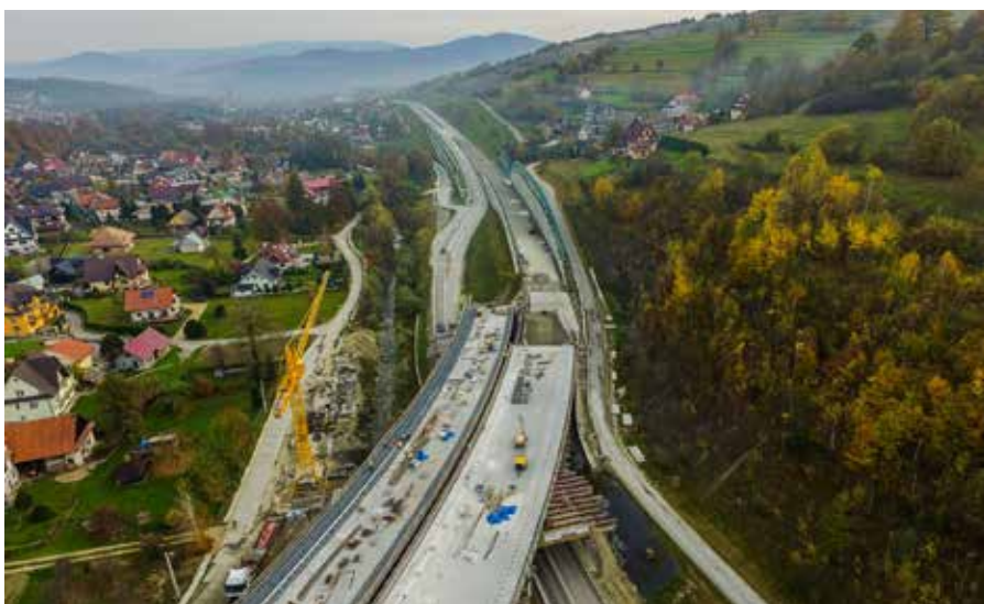
FOT. 1 Włączenie realizowanej S7 do istniejącej drogi w m. Lubień
