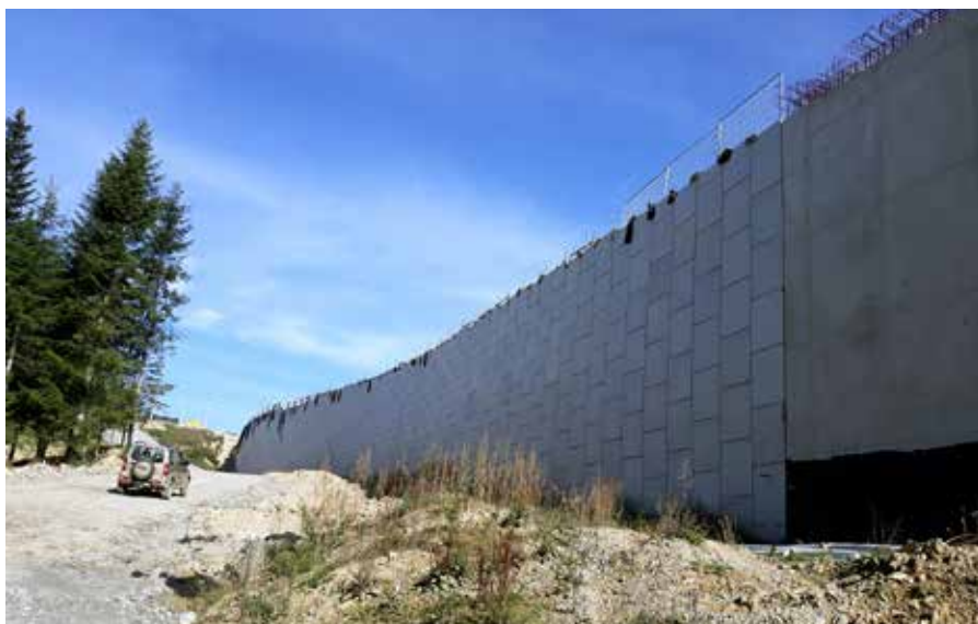
FOT.13 Konstrukcja muru oporowego z wykorzystaniem taśm z tworzywa sztucznego i oblicowaniem z prefabrykowanych paneli żelbetowych
