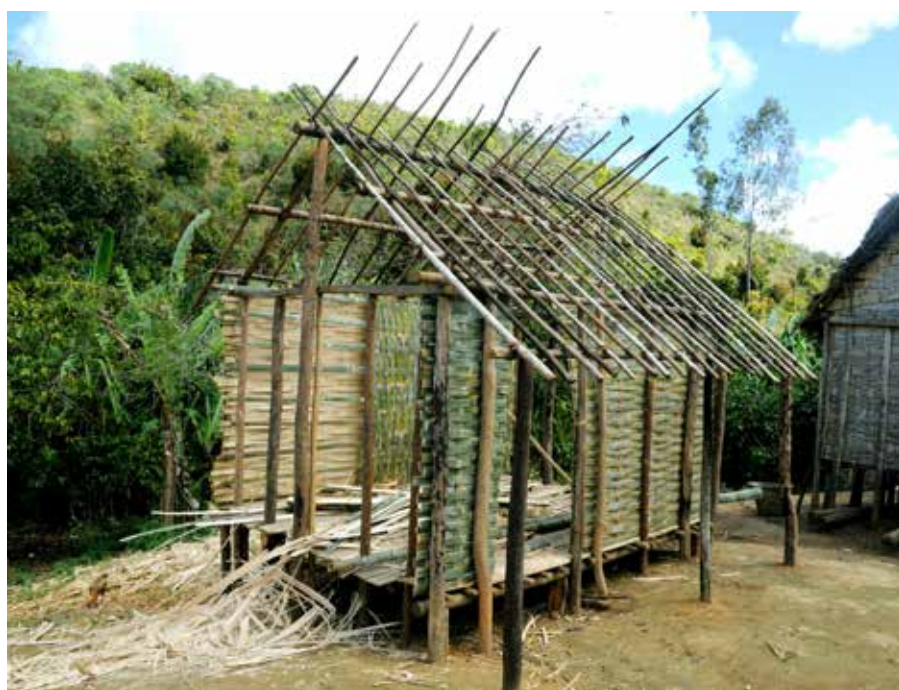
Fot. 5. Budowa domu – widoczny szkielet ścian i konstrukcja dachu oraz zakładana właśnie obudowa ścian
