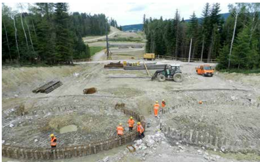
FOT. 10 Ob. 22- posadowienie na kesonach
