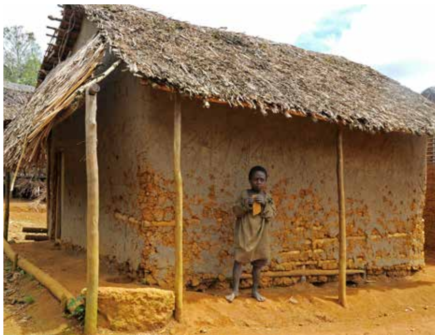
Fot. 14. Polepione gliną ściany jednego z budynków wioski
