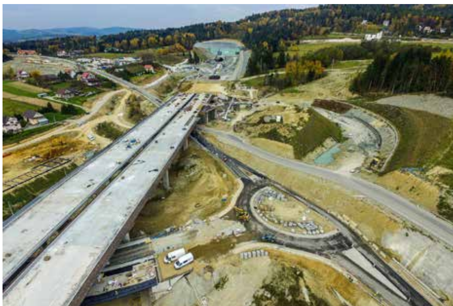
FOT. 8. Węzeł Skomielna Biała – widok na portal południowy tunelu
