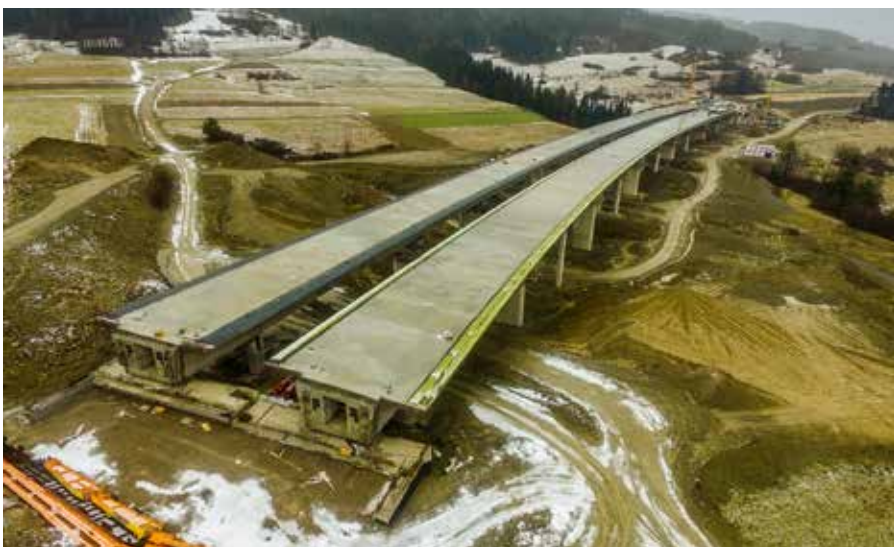
FOT. 2 Obiekt 10-11 zrealizowany w technologii nasuwania podłużnego
