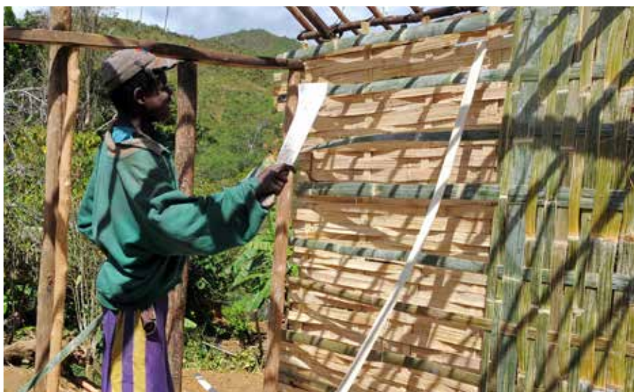
Fot. 8. Budowa domu – praca przy wyplataniu ścian
