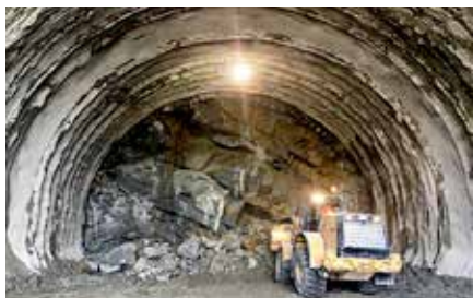
FOT. 4 Czoło tunelu i stalowe żebra
