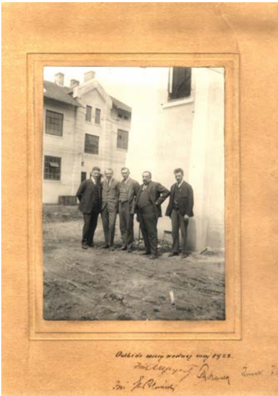
Kadra kierownicza KGM podczas odbioru wieży wodnej, 1922
