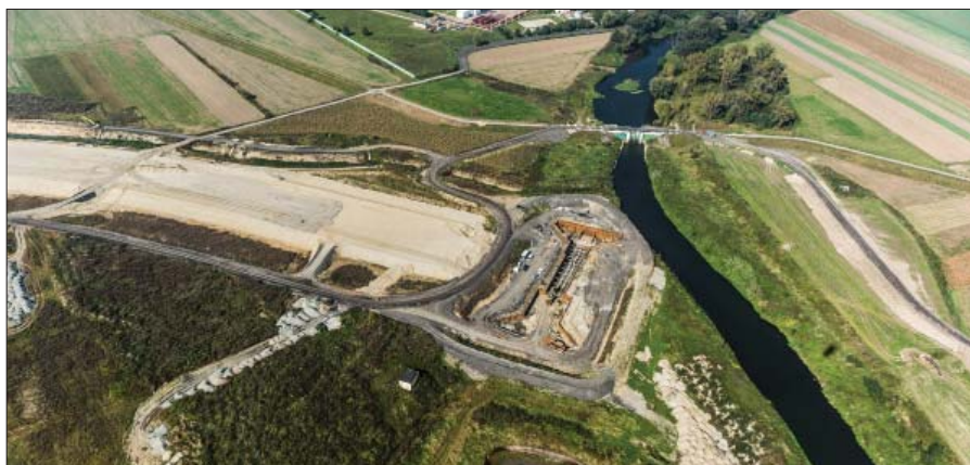
Widok na wykop pod budowlę upustową do Odry Miejskiej
