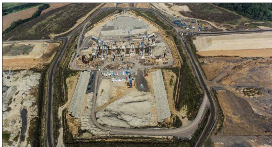
Widok na wykop pod budowlę przelewowo-spustową i kanał odpływowy
