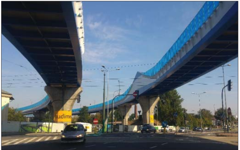
Fragment nowej łącznicy kolejowej Kraków Zabłocie – Kraków Krzemionki
