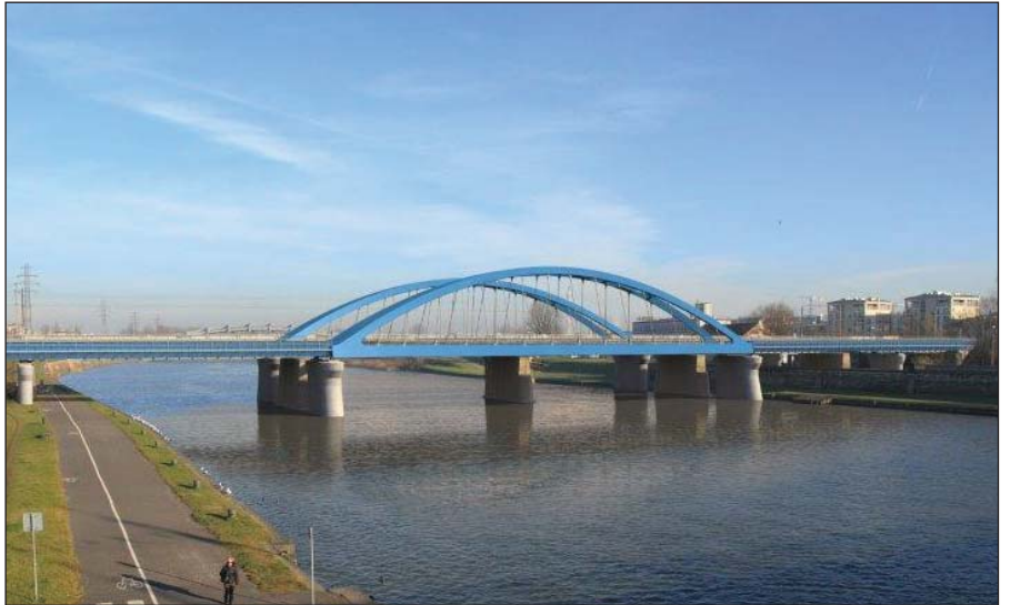
Modernizacja linii kolejowej E30 Kraków Główny – Rudzice, most przez Wisłę
