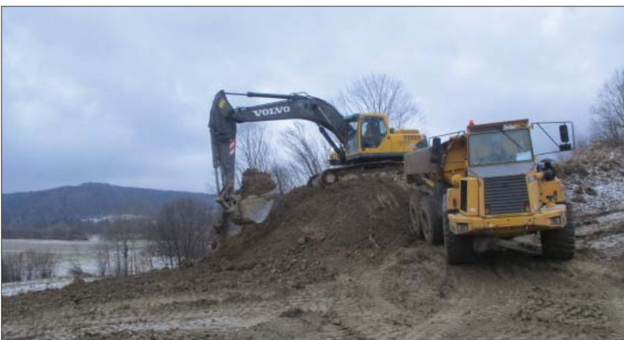
Roboty ziemne - 719+300. Budowa nowej „zakopinaki“ pod nadzorem mgr. inż. Jana Kowalczyka
