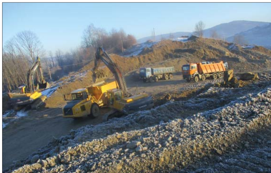
Obiekt nr 5 prace przygotowawcze KM714+450. Budowa nowej „zakopianki“ pod nadzorem mgr. inż. Jana Kowalczyka
