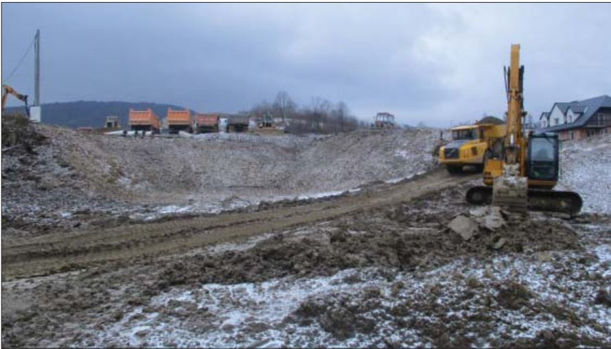
Roboty ziemne km 714+100. Budowa nowej „zakopinaki“ pod nadzorem mgr. inż. Jana Kowalczyka
